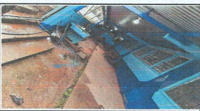
Foto 6: PINTURA EN MUROS EXTERIORES E INTERIORES
