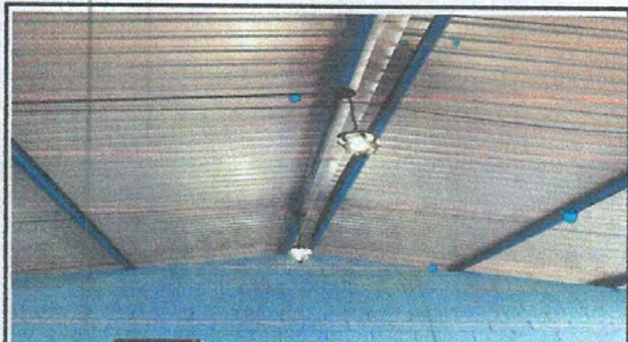
Foto 3: REPARACION DE SISTEMA ELECTRICO
