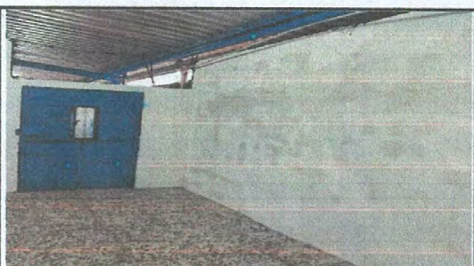
Foto 4: REPARACION DE REPELLO Y CERNIDO DE PAREDES Y PISO (granito)
