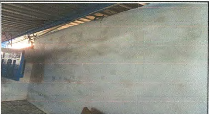
Foto 4: REPARACION DE REPELLO Y CERNIDO DE PAREDES
