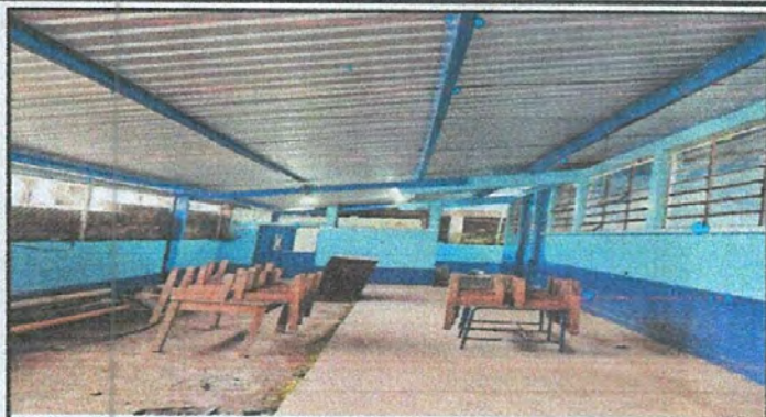
Foto1: PINTURA EN MUROS EXTERIORES E INTERIORES
