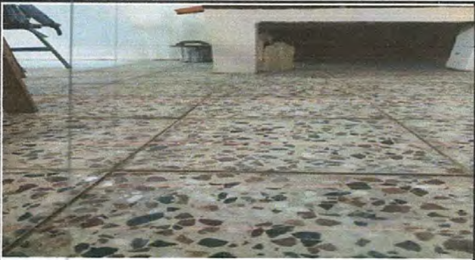
Foto 3: REPARACION DE COCINA (instalacion de piso granito)
