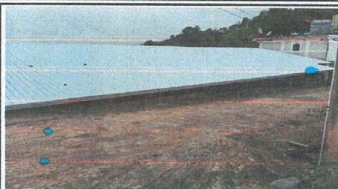
Foto 2: CUBIERTA DE LAMINA, CANALES.
