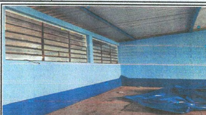
Foto 2: PINTURA EN MUROS EXTERIORES E INTERIORES
