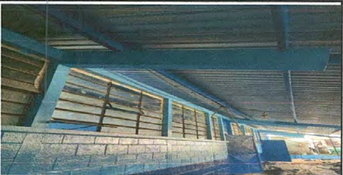
Foto 5: PINTURA EN MUROS EXTERIORES E INTERIORES
