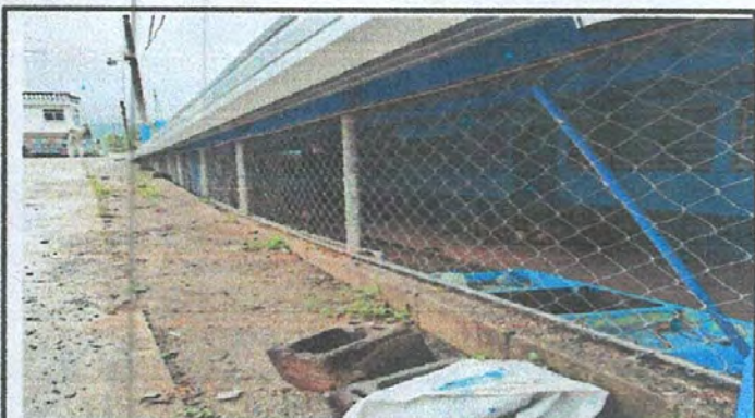
Foto 3: REPARACION DE TUBO HG Y MALLA GALVANIZADO
