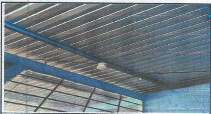
Foto 5: REPARACION DE SISTEMA ELECTRICO
