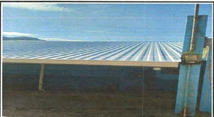
Foto 2: CUBIERTA DE LAMINA, CANALES, REPARACION DE TUBOS Y MAYAS GALVANIZADA.
