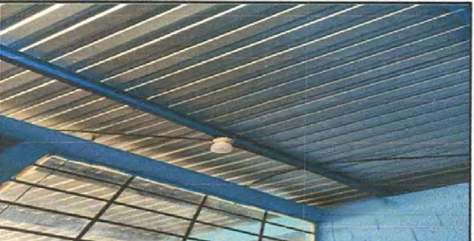
Foto 6: REPARACION DE SISTEMA ELECTRICO
