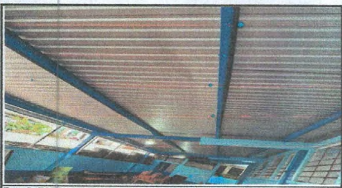
Foto 5: ESTRUCTURA DE TECHO
