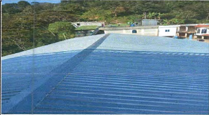
Foto1: CUBIERTA DE LAMINA
