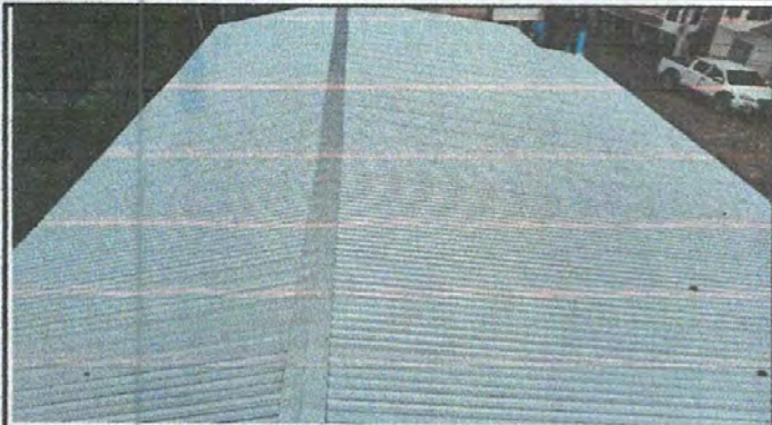
Foto1: CUBIERTA DE LAMINA
