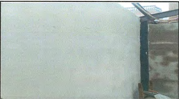
Foto 4: REPARACION DE REPELLO Y CERNIDO DE PAREDES
