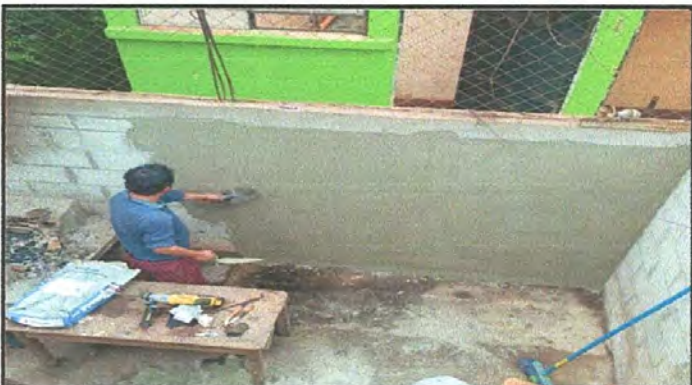
Foto 4: REPARACION DE REPELLO Y CERNIDO DE PAREDES
