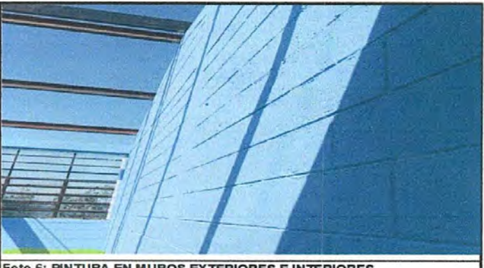
Foto 6: PINTURA EN MUROS EXTERIORES E INTERIORES
