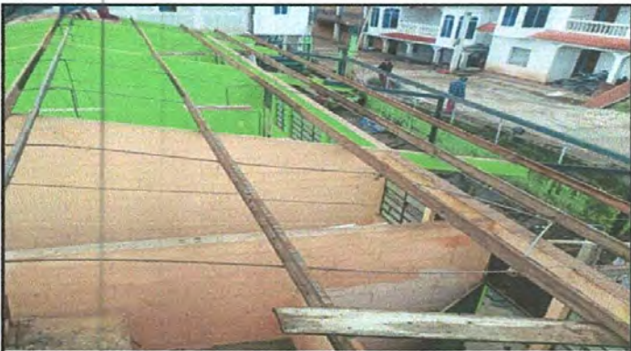
Foto 3: CUBIERTA DE LÁMINA
