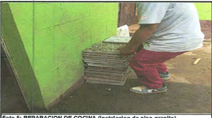
Foto 5: REPARACION DE COCINA (Instalacion de piso granito)
