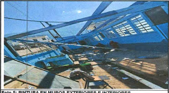
Foto 5: PINTURA EN MUROS EXTERIORES E INTERIORES
