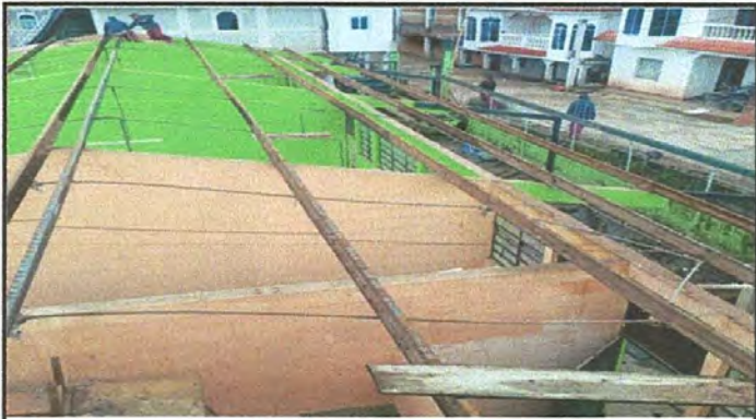
Foto 2: CUBIERTA DE LÁMINA
