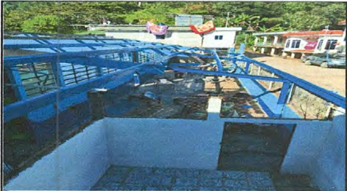
Foto 3: ESTRUCTURA DE TECHO, REPELLO Y CERNIDO DE PAREDES, REPARACION DE COCINA (instalacion de piso granito)
