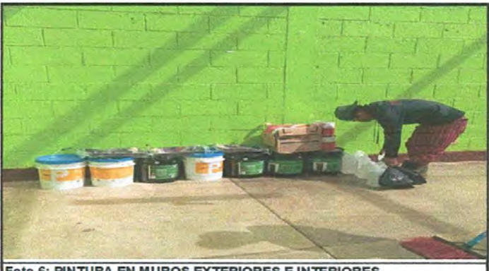
Foto 6: PINTURA EN MUROS EXTERIORES E INTERIORES
