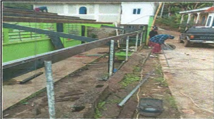
Foto1: MUROS PERIMENTALES (Reparacion de tubo hg y malla galvanizada)
