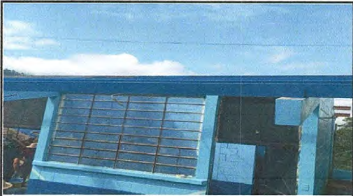
Foto 2: ESTRUCTURA DE TECHO
