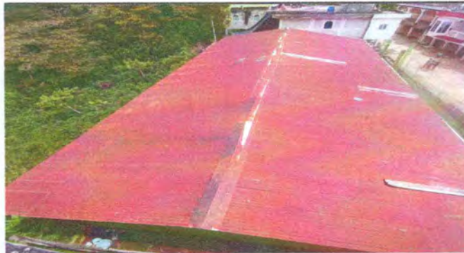
Foto 2: SUSTITUCION DE LAMINA
