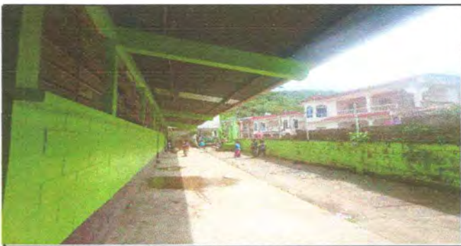
Foto 11: PINTURA EN PAREDES EXTERIORES
