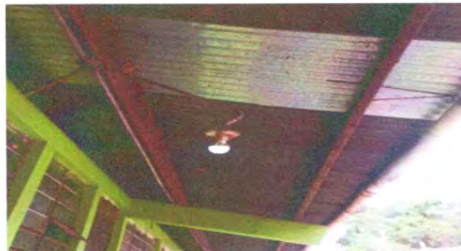
Foto 4: ESTRUCTURA DE TECHO (Mantenimiento a estructura de soporte de metal, lijado y aplicación de pintura)
