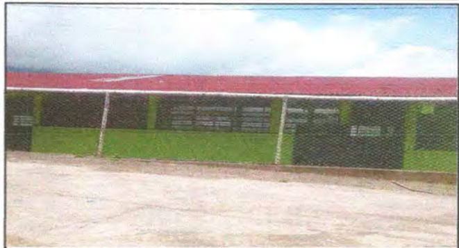
Foto 14: SUSTITUCION DE MALLA GALVANIZADA
