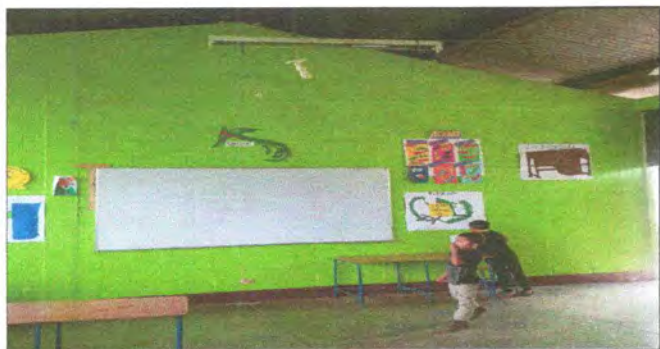
Foto 11: PINTURA EN PAREDES INTERIORES
