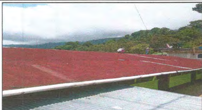
Foto 7: SUSTITUCION DE CANAL
