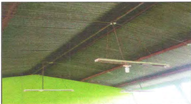
Foto 15: REPARACIÓN DE SISTEMA ELÉCTRICO (sustitucion de lamparas colgantes)
