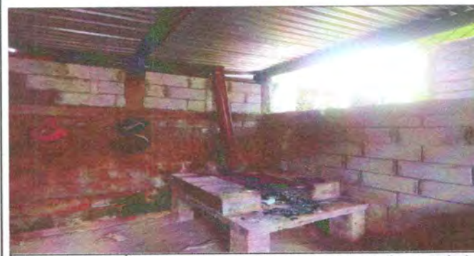
Foto 5: REPARACIÓN DE COCINA (Cambio de plancha, repello, ceramica)
