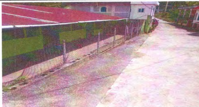
Foto1: SUSTITUCION DE LAMINA
