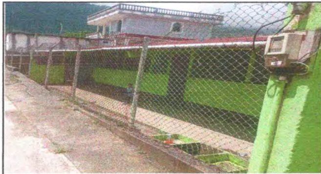
Foto 13: SUSTITUCION DE MALLA GALVANIZADA
