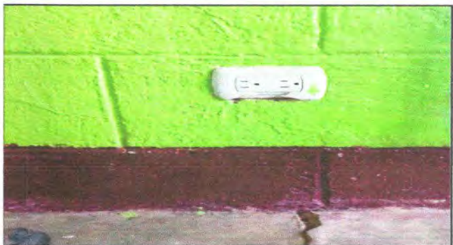
Foto 16: SUSTITUCION DE CABLEADO, TOMACORRIENTES, FLAFONERAS, APAGADORES...
