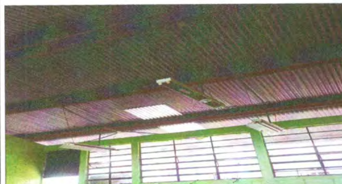
Foto 3: ESTRUCTURA DE TECHO (Mantenimiento a estructura de soporte de metal, lijado y aplicación de pintura))
