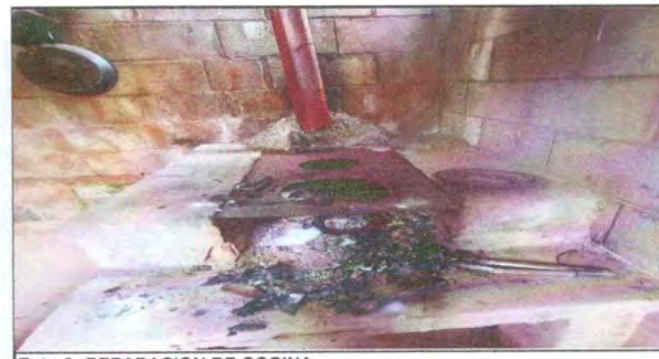
Foto 6: REPARACION DE COCINA
