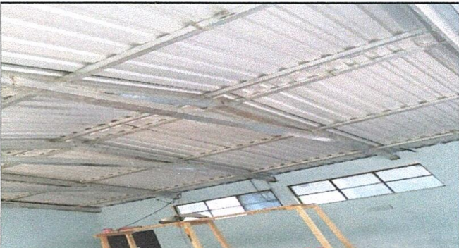
Foto 4: MANTENIMIENTO A ESTRUCTURA DE SOPORTE DE METAL
