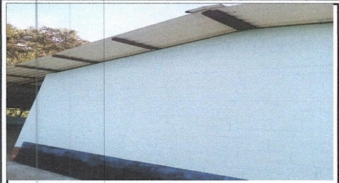
Foto1: PINTURA EN MUROS EXTERIORES E INTERIORES
