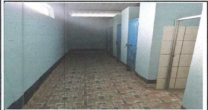
Foto 3: SUSTITUCIÓN DE PISO EN SANITARIOS
