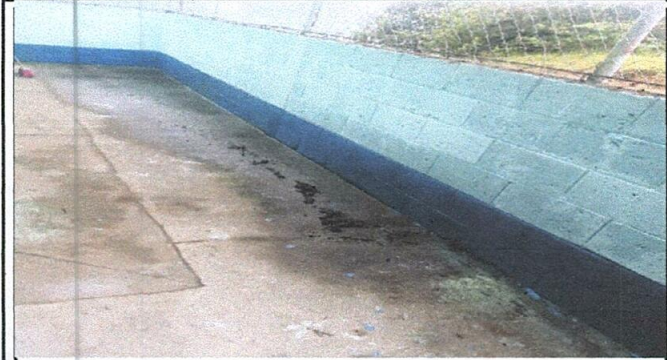
Foto1: PINTURA EN MUROS EXTERIORES E INTERIORES
