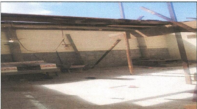
Foto 4: CAMBIO DE SOPORTE DE MADERA POR METAL
