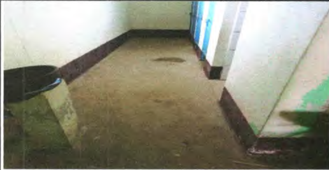
Foto7: SUSTITUCIÓN DE PISO DE SANITARIOS
