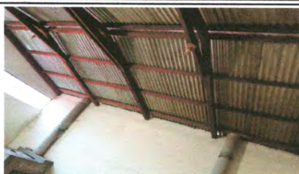
Foto 2: MANTENIMIENTO A ESTRUCTURA DE SOPORTE DE METAL
