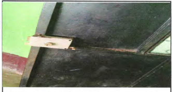
Foto 10: SUSTITUCIÓN DE CHAPAS
