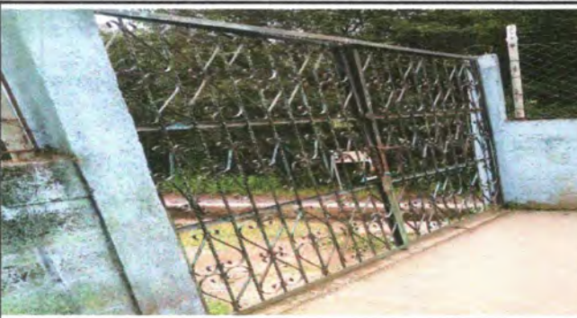
Foto 9: MANTENIMIENTO DE PORTÓN
