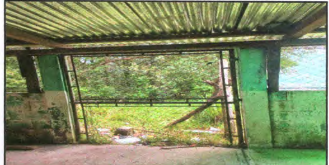
Foto 8: SUSTITUCIÓN DE PORTÓN
