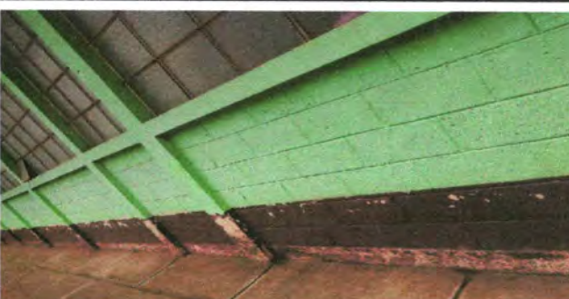
Foto 4: PINTURA EN MURO
