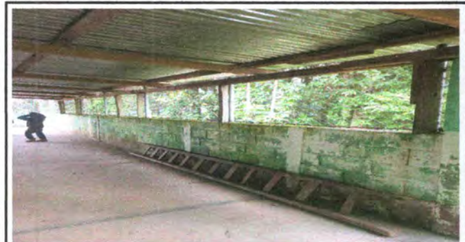
Foto 5: PINTURA EN MURO
