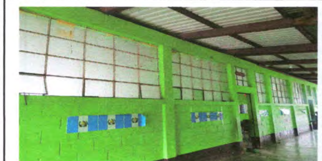
Foto 3: SUSTITUCIÓN DE VENTANAS DE METAL CON VIDRIOS
