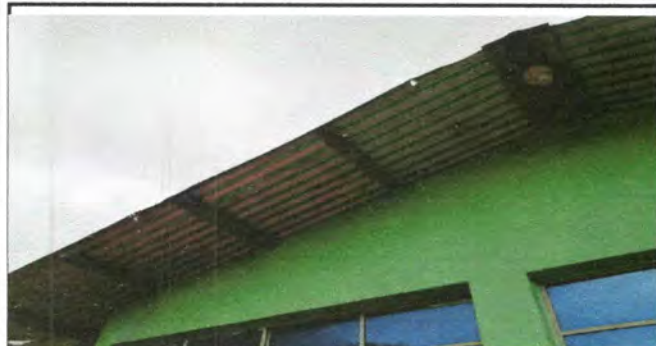
Foto1: SUSTITUCIÓN DE LÁMINA EN CUBIERTA DE TECHO DE COCINA
