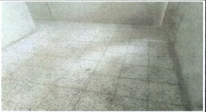
Foto 4: SUSTITUCIÓN DE TORTA DE CONCRETO POR PISO GRANITO
