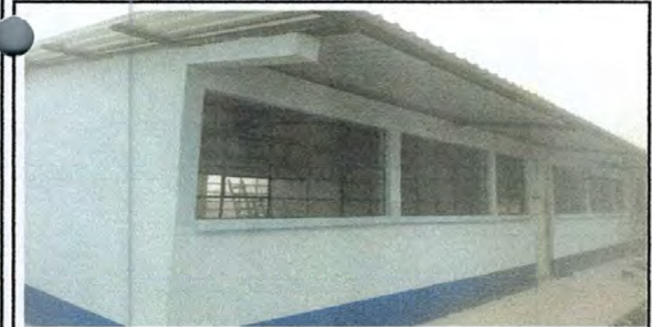
FOTO: 11 SUSTITUCIÓN DE PINTURA GENERAL INTERIOR Y EXTERIOR
