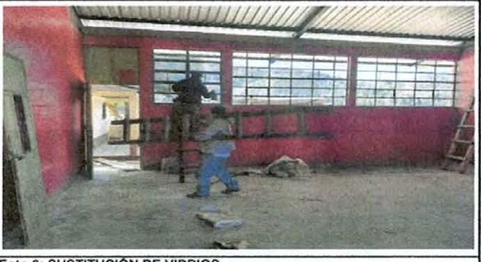
Foto 6: SUSTITUCIÓN DE VIDRIOS
