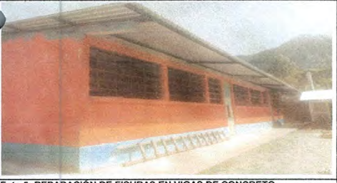
Foto 5: REPARACIÓN DE FISURAS EN VIGAS DE CONCRETO
