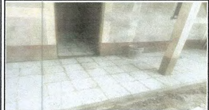
FOTO: 9 SUSTITUCIÓN DE TORTA DE CONCRETO POR PISO GRANITO
