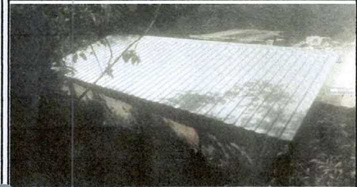
FOTO: 7 SUSTITUCIÓN DE LÁMINA POR LÁMINA TROQUELADA CALIBRE 26
