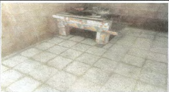
FOTO: 10 INSTALACIÓN DE AZULEJO EN ESTUFA RURAL
