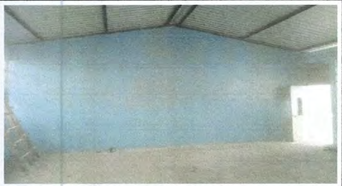
Foto 3: SUSTITUCIÓN DE PUERTAS DE METAL
