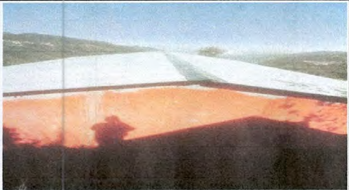
Foto1: SUSTITUCIÓN DE LÁMINA POR LÁMINA TROQUELADA CALIBRE 26
