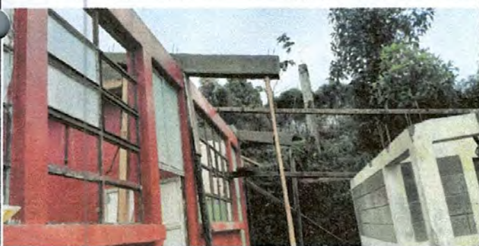
5. REPARACIÓN DE FISURAS EN VIGAS DE CONCRETO
