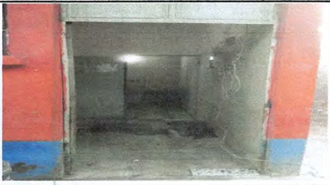
3. SUSTITUCIÓN DE PUERTAS DE METAL
