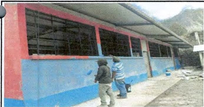
FOTO: 11 SUSTITUCIÓN DE PINTURA GENERAL INTERIOR Y EXTRIOR
