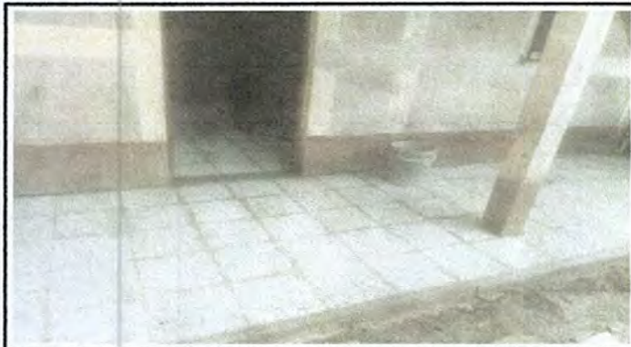
FOTO: 9 SUSTITUCIÓN DE TORTA DE CONCRETO POR PISO GRANITO
