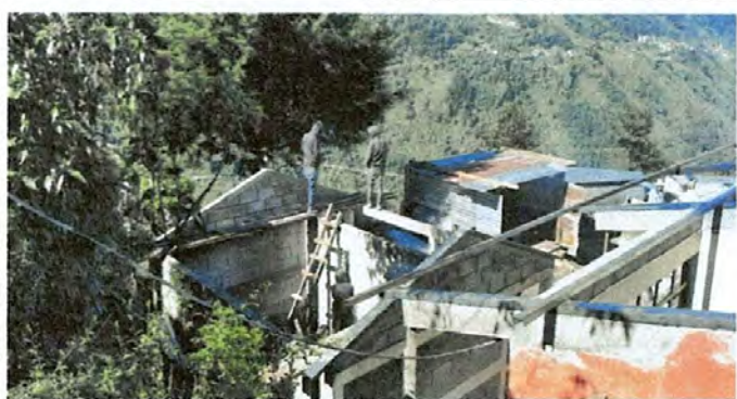
FOTO: 8 SUSTITUCIÓN DE ESTRUCTURA DE MADERA POR ESTRUCTURA DE METAL
