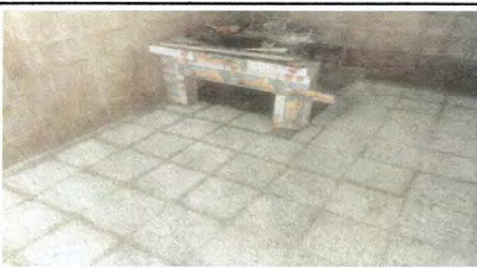
FOTO: 10 INSTALACIÓN DE AZULEJO EN ESTUFA RURAL
