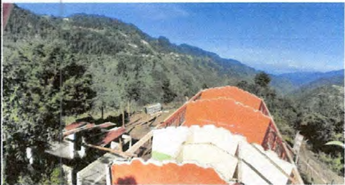
1. SUSTITUCIÓN DE LÁMINA POR LÁMINA TROQUELADA CALIBRE 26
