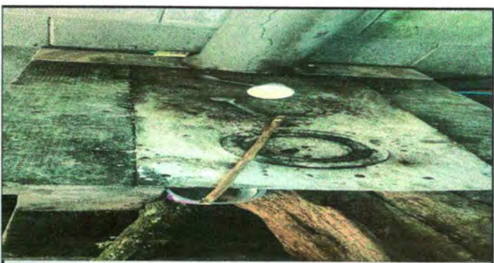
FOTO 6: SUSTITUCIÓN DE PLANCHA DE METAL DE COCINA
