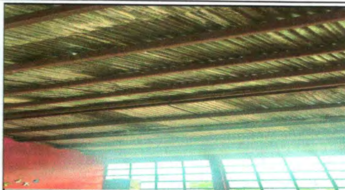
FOTO 2: SUSTITUCIÓN DE ESTRUCTURA DE METAL POR METAL
