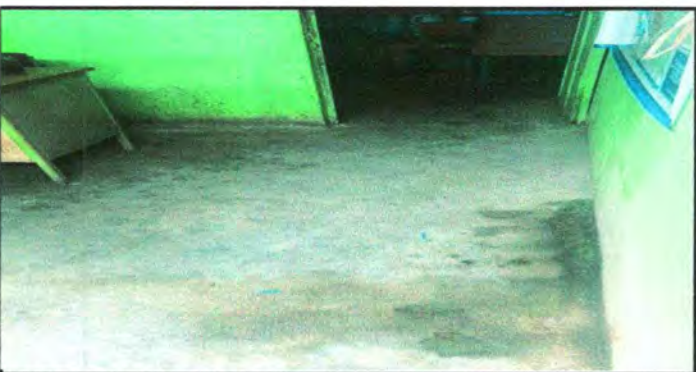
FOTO 5: SUSITTUCIÓN DE PISO
