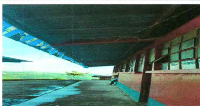
FOTO 5 : REPARACION DE VIGAS
