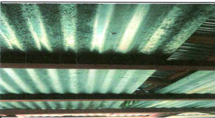
FOTO 3: SUSTITUCIÓN DE ESTRUCTURA DE MADERA POR METAL
