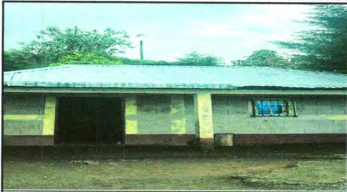
FOTO 1: SUSTITUCIÓN DE LAMINA
