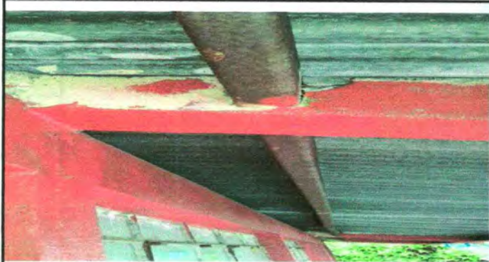
FOTO 1: REPARACION DE FISURAS DE VIGAS
