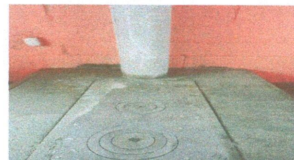
Mantenimiento y sustitución de estufa rural (completa)
