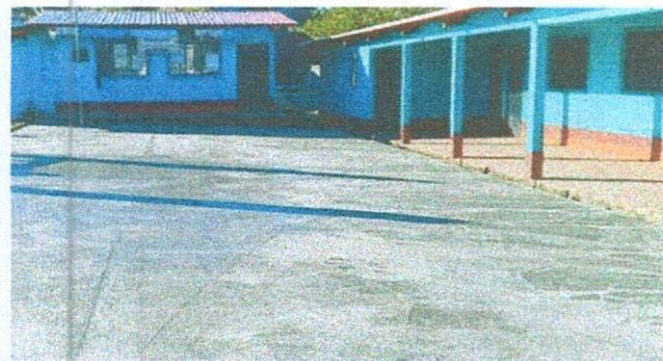
Foto 5: Sustitución de losa de patio
