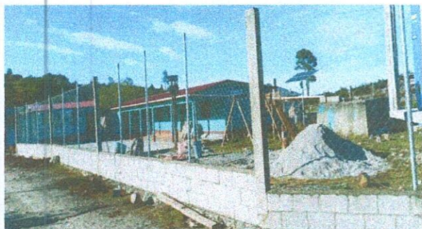
Foto 1: Sustitución de cerco de alambre de pua a muro perimetral de block con tubo hg y malla galvanizada, soleras intermedias y columnas.
