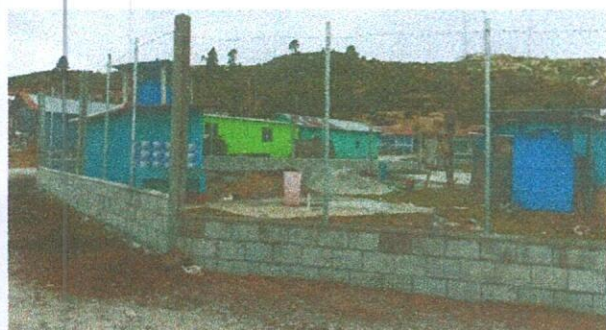
Foto 3: Muro perimetral desde varios ángulos
