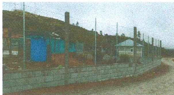
Foto 2: Muro perimetral desde varios ángulos
