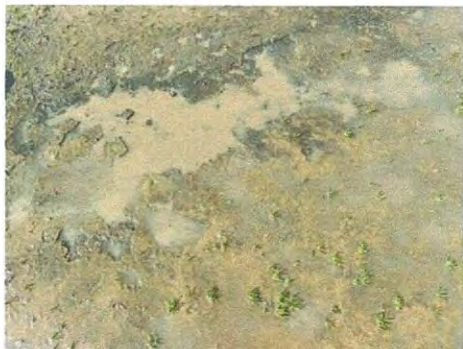
Foto 2: Levantado de losa en mal estado.
