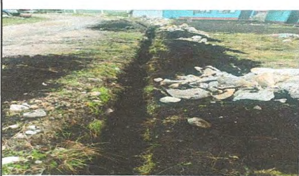
Foto 2: Zanjado para sustitución de muro perimetral.
