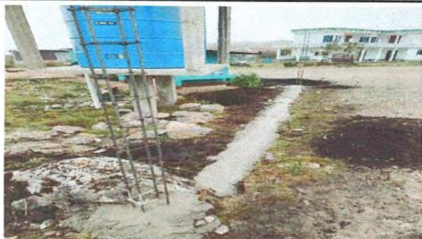
Foto 4: Relleno de zanjado con cemento y fundición de columnas.
