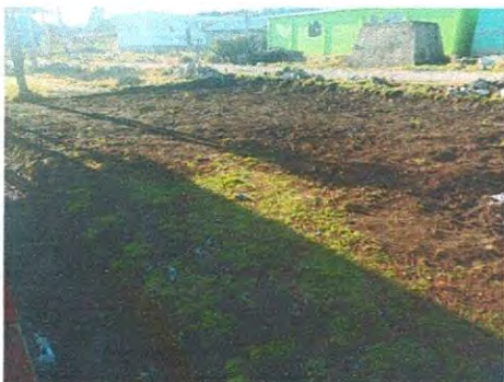
Foto 3: Terraplén después de quitada la losa de patio
