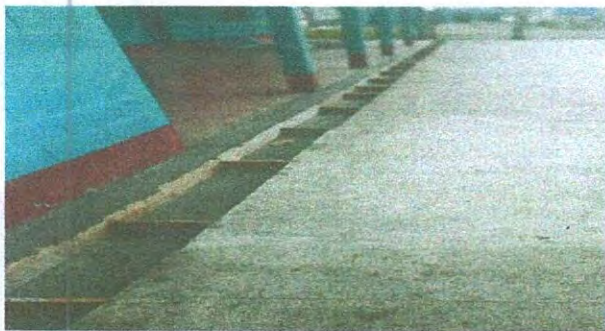
Foto 3: Sustitución de losa de patio
