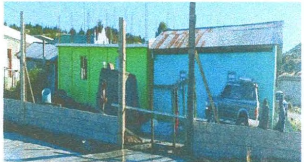
Foto 2: Sustitución de muro perimetral y cambio de portón
