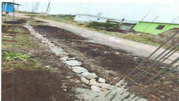
Foto 3: Llenado de zanjado con piedra para sustitución de muro perimetral
