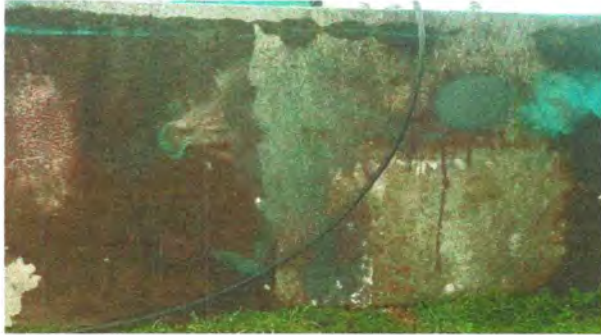
Foto 13: Sustitución de depósito de agua 1700 lt
