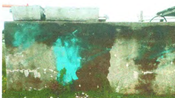
Foto 12: Reparación y mantenimiento de cisternas/ depósitos de agua
