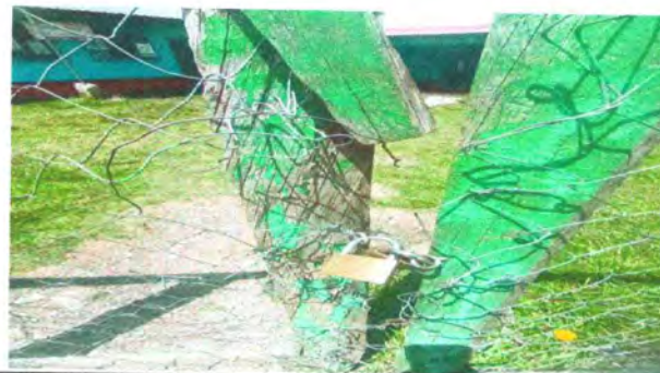
Foto 2: Sustrucción de portón de malla y madera a portón de malla y tubo galvanizado de dospulgadas de 4 mts de ancho con puerta central.
