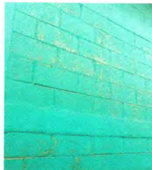
Foto 8: Pintura en muros exteriores e interiores
