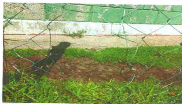
Foto 6: Sustrucción de cerco de alambre de pua a muro perimetral de block con tubo hg y malla galvanizada, soleras intermedias y columnas.
