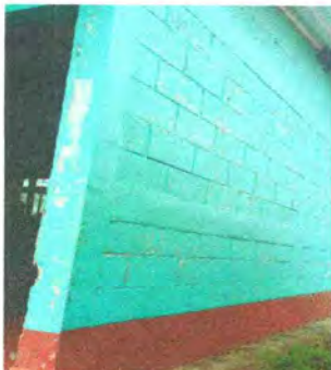
Foto 7: Pintura en muros exteriores e interiores
