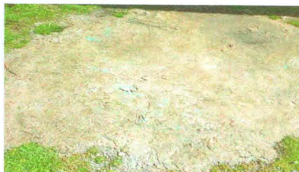
Foto 10: Reparación de planchas de concreto de patio
