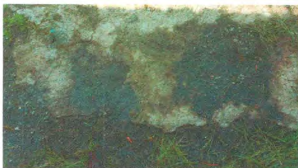
Foto 9: Reparación de planchas de concreto de patio
