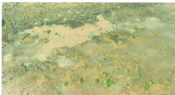
Foto 11: Reparación de planchas de concreto de patio
