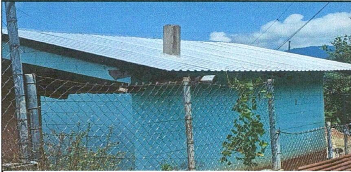
Foto 1: CAMBIO DE TECHO
