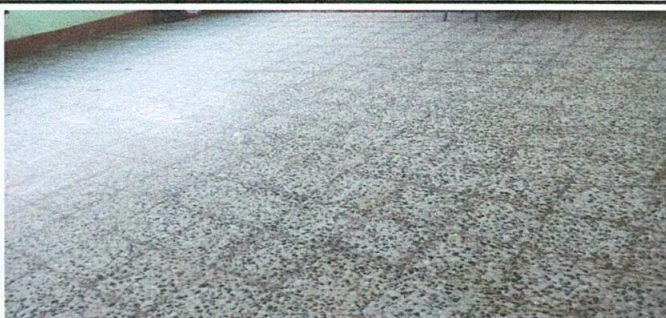
Foto 5: CAMBIO DE PISO
