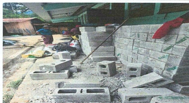
Foto 4: MURO DE CONTENCION
