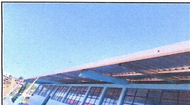
Foto 4: SUSTITUCIÓN DE CANAL DE PVC Y REPARACIÓN DE BAJADA DE AGUA PLUVIAL FINALIZADO
