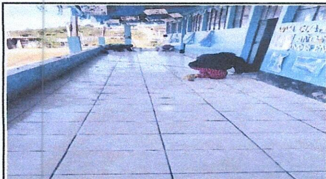
Foto 3: SUSTITUCIÓN DE PISO DE TORTA DE CONCRETO POR PISO DE GRANITO FINALIZADO
