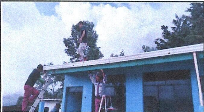
Foto 4: SUSTITUCIÓN DE CANAL DE PVC Y REPARACIÓN DE BAJADA DE AGUA PLUVIAL, TUBO PVC 3"
