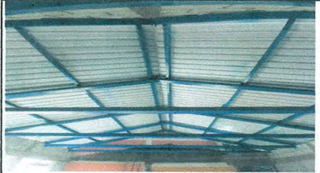
Foto 2: Estructura de techo y lamina de cocina.
