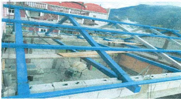
Foto1: Finalización de estructura de techo.
