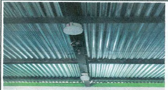
Foto 6: Sustitución de focos ahorradores.
