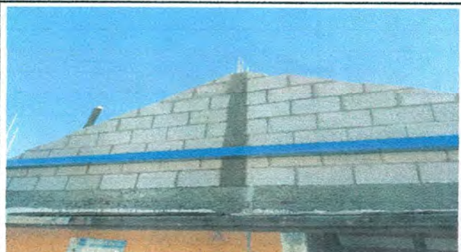
Foto 4: Inicio de colocación de la estructura del techo.
