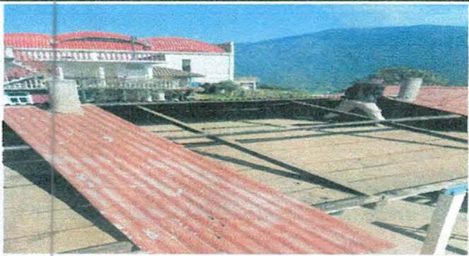
Foto1: Quitando la lámina de la cocina.
