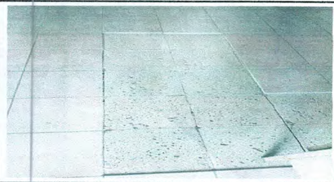
Foto 5: Desmantelación del piso cerámico.
