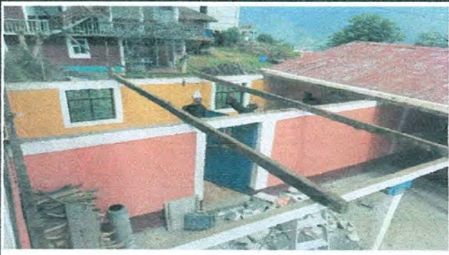
Foto 2: Quitando la estructura de techo de madera.
