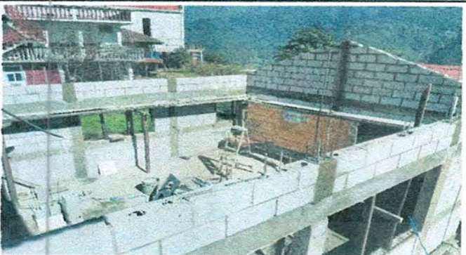
Foto 3: Mejoramiento de la pared de la cocina.
