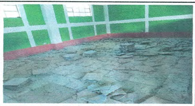
Foto 6: Desmantelación del piso cerámico.
