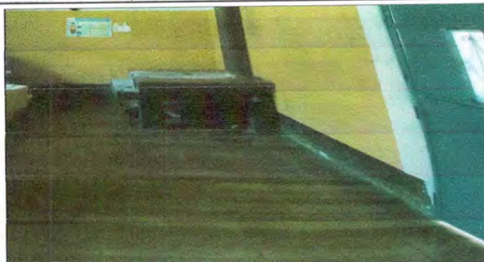
Foto 11: Parte del piso de cocina.
