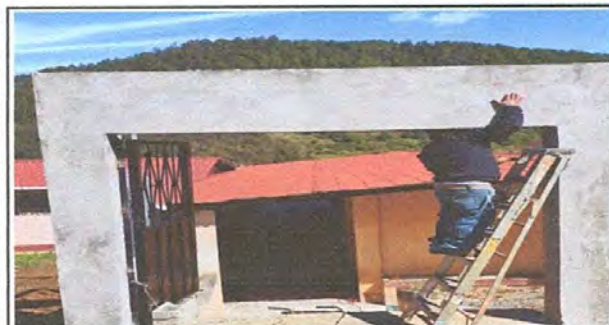
Foto 5: Sustitución de columnas de madera por columnas de concreto
