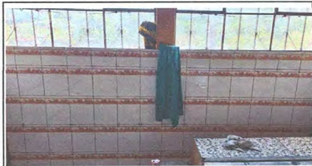
Foto1: Mejoramiento Cocina paredes (azulejo)
