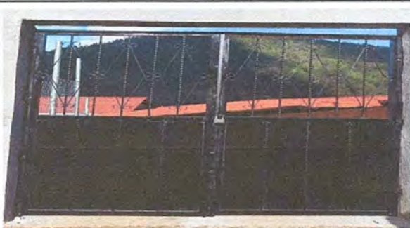
Foto 4: Sustitución de portón
