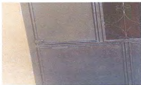
Foto 7: Sustitución de chapa
