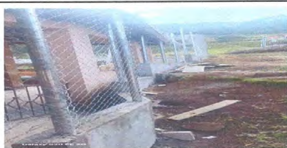
Foto 3: Mejoramiento malla en Muro Perimetral
