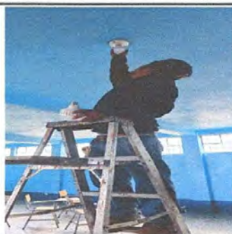
Foto 8: Sustitución de lamparas
