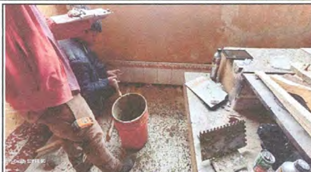
Foto1: Mejoramiento Cocina paredes (azulejo)
