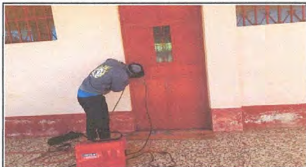
Foto 7: Sustitución de chapa
