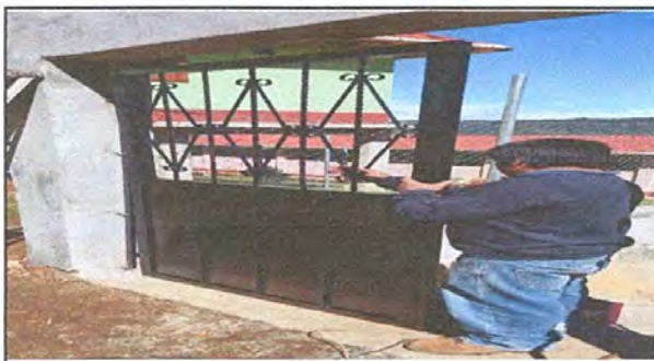
Foto 4: Sustitución de portón
