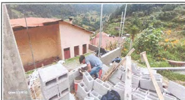
Foto 3: Mejoramiento malla en Muro Perimetral
