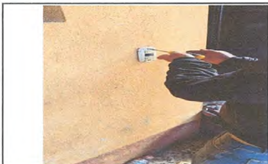
Foto 9: Sustitución de interruptores
