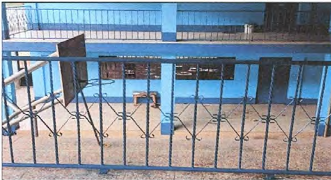
Foto 9: MANTENIMIENTO DE BARANDAS EN EL SEGUNDO NIVEL
