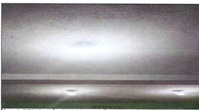
Foto 6: REPARACIÓN DE SISTEMA ELÉCTRICO
