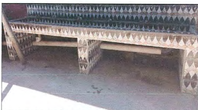
Foto 4: MEJORAMIENTO DE AZULEJOS EN LAVAMANOS
