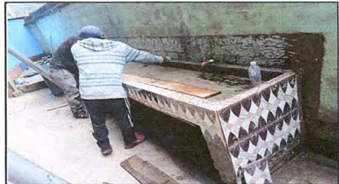
Foto 4: MEJORAMIENTO DE AZULEJOS EN LAVAMANOS
