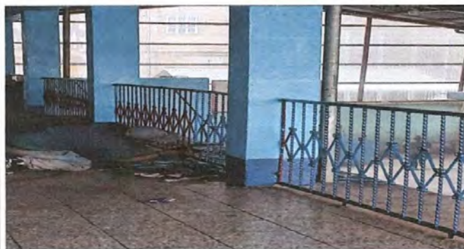
Foto 9: MANTENIMIENTO DE BARANDAS EN EL SEGUNDO NIVEL
