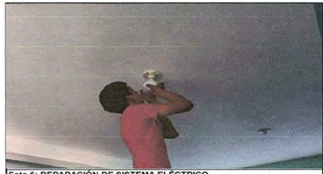
Foto 6: REPARACIÓN DE SISTEMA ELÉCTRICO
