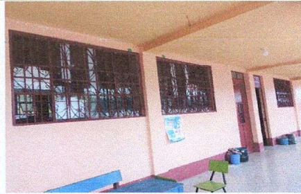
Foto 2: colocación de balcones a ventanas
