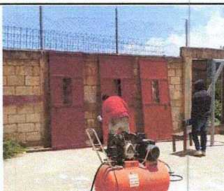
Foto 3: mantenimiento a puertas (pintura anticorrosiva)
