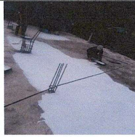
Foto 8: impermeabilización de losa
