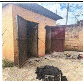
Foto 4: sustitución de puertas de servicios sanitarios
