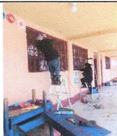
Foto 2: colocación de balcones a ventanas
