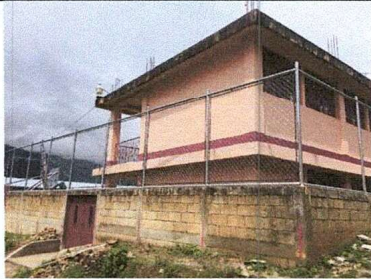
Foto 7: mejoramiento de circulación perimetral
