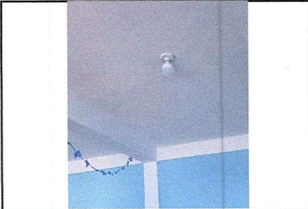
Foto 7: Sustitución de focos ahorradores
