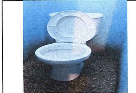
Foto 2: Sustrución de inodoros
