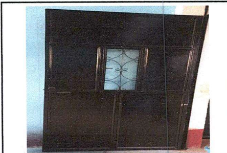
FOTO 1: PUERTAS DE METAL, mantenimiento a estructura (lijado y aplicación de pintura)
