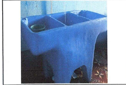
Foto 10: Sustitución de pila plástica de dos lavadoras
