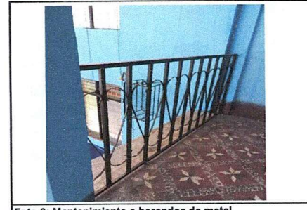
Foto 6: Mantenimiento a barandas de metal
