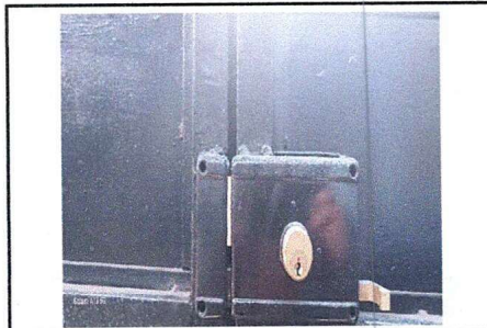
FOTO 3. Sustrución de chapa
