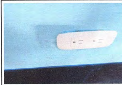
Foto 8: Sustitución de interruptores dobles
