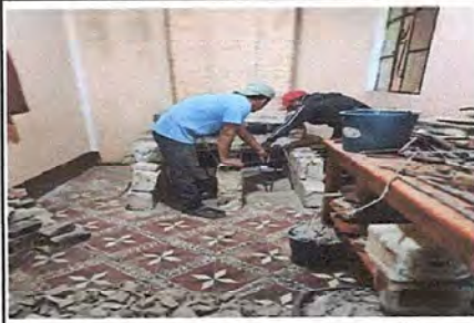
FOTO 4. Sustitución de pincha de 3 hornillas.
