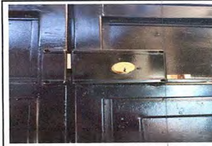
FOTO 3. Sustitución de chapa
