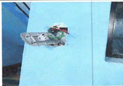
Foto 9: Sustitución de toma corrientes dobles
