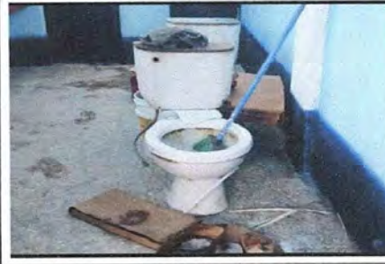
Foto 2: Sustitución de inodoros
