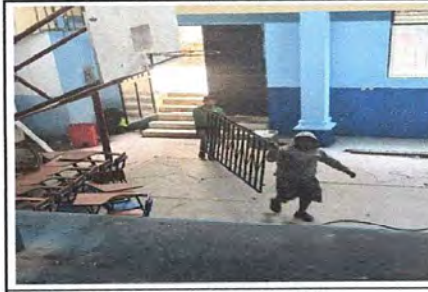
Foto 6: Mantenimiento a barandas de metal
