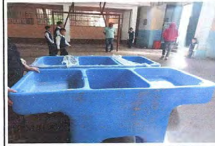
Foto 10: Sustitución de pila plástica de dos lavadoras
