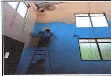
Foto 5. Pintura en muros exteriores e interiores
