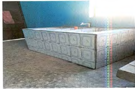
Foto 4: Sustrucción de una pila
