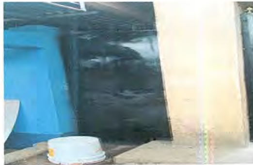
Foto 2: Mejoramiento del portón 2
