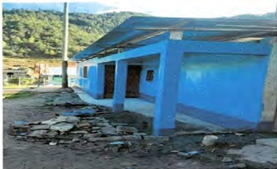
Foto7: Pinturas de muros interiores y exteriores
