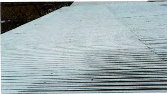
Foto 5: Sustrucción de techo de cocina
