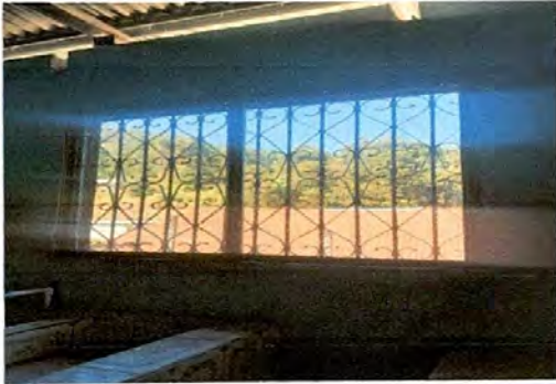
Foto 1: Sustrucción de ventanas
