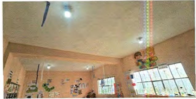
Foto 6: Reparación de Sistema Eléctrico
