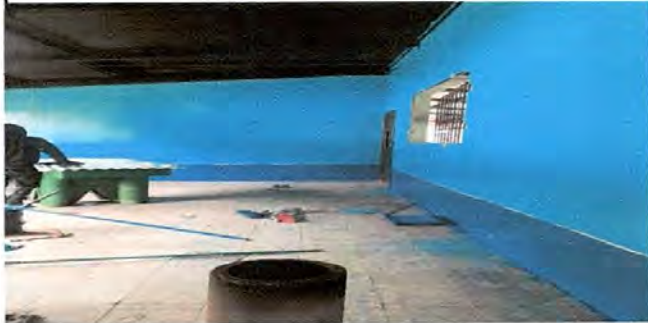
Foto7: Pinturas de muros interiores de la cocina
