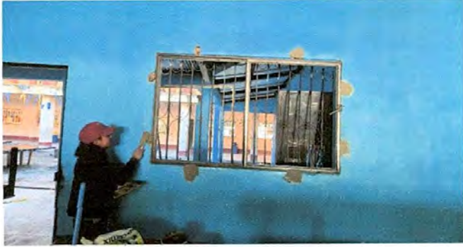
Foto1: Sustitución de ventanas
