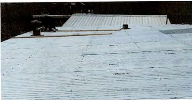
Foto 5: Sustitución de techo de cocina
