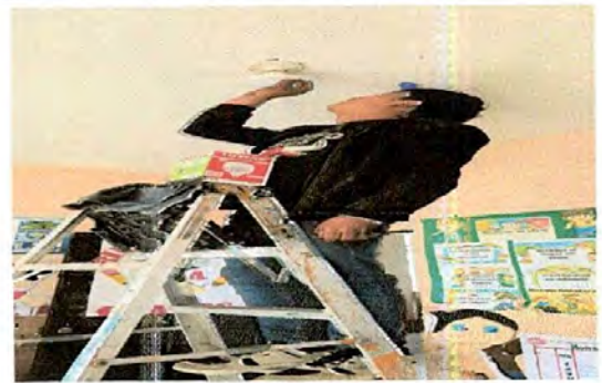
Foto 6: Reparación de Sistema Eléctrico
