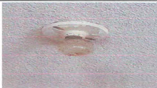
Foto 6: Reparación de Sistema Eléctrico
