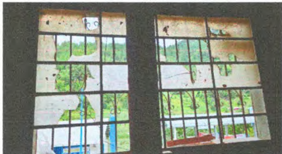
Foto 1: Sustrucción de ventanas
