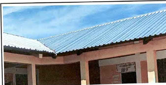
Foto 6: Servicio sanitario: Finalización de renglón seis.
