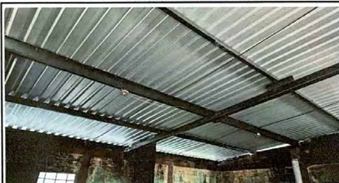
Foto 2: Cocina uno: Finalización de renglón dos.
