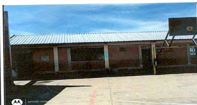
Foto 3: Cocina dos: Finalización de renglón tres.
