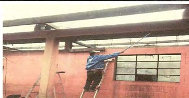
Foto 2: cocina uno: Lijado de estructura de metal
