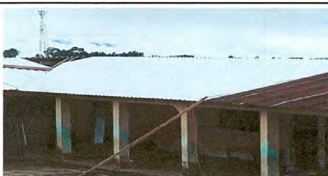
Foto 6: Servicio sanitario: Sustituyendo lamina por lamina troquelada calibre 26
