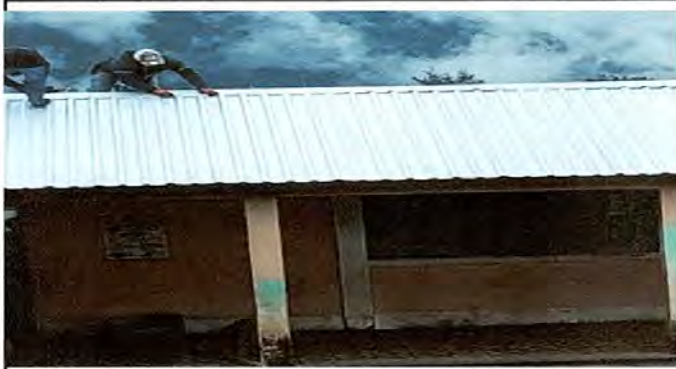
Foto7:Aula dos:Sustituyendo lamina por lamina troquelada calibre 26
