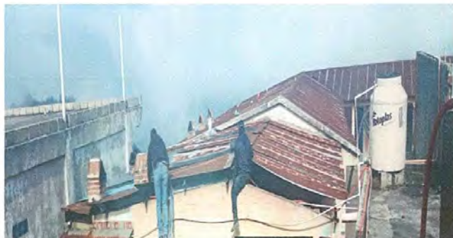
Foto1: Cocina uno: Desmontando lámina
