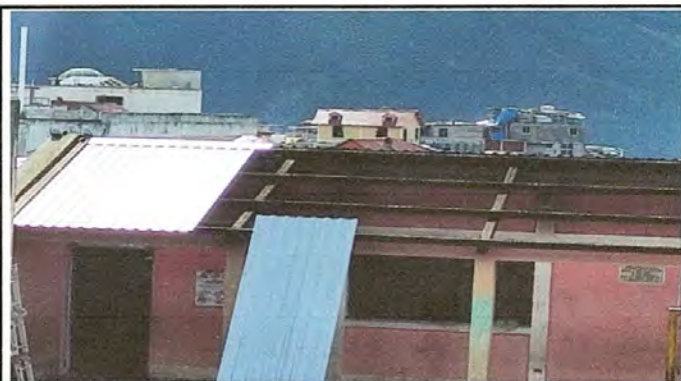
Foto 3: Cocina dos: sustituyendo lamina por lamina troquelada calibre 26
