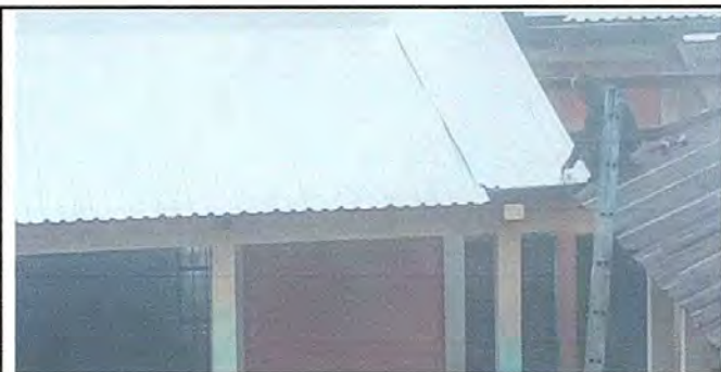
Foto 5: Bodega: Sustituyendo lamina por lamina troquelada calibre 26
