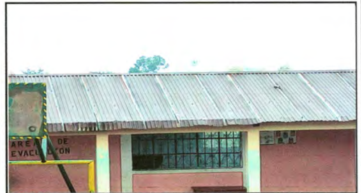
Foto 4: Sustrucción techo de aula uno: láminas troqueladas y capotes calibre 26
