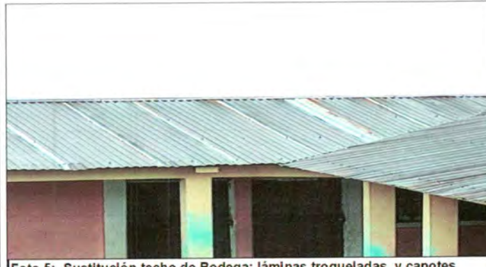
Foto 5: Sustrucción techo de Bodega: láminas troqueladas y capotes calibre 26
