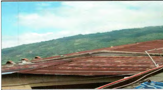
Foto1: Sustrucción techo de cocina uno: láminas troqueladas y capotes calibre 26
