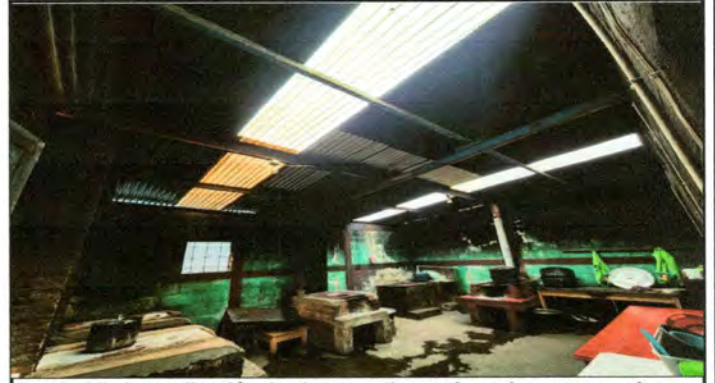
Foto2: Lijado y aplicación de pintura anticorrosiva color negro en vigas de metal.
