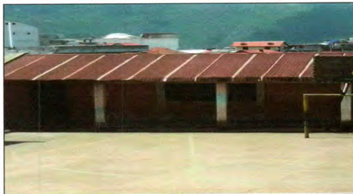
Foto3: Sustrucción techo de cocina dos: láminas troqueladas y capotes calibre 26
