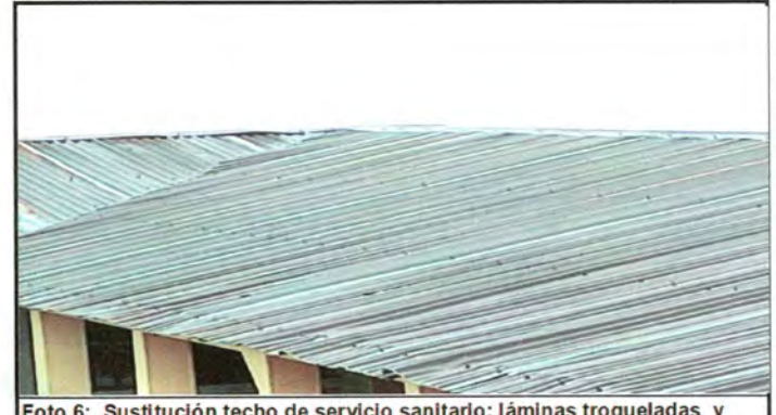
Foto 6: Sustrucción techo de servicio sanitario: láminas troqueladas y capotes calibre 26
