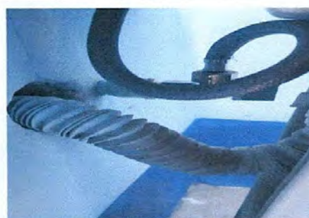
Foto 6: sustitución de mangueras de agua para lavamanos
