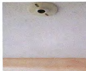
Foto 2: sustitución de plafoneras
