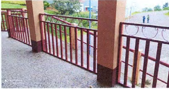
Foto 19: sustitución de barandas de metal (260 X100)(366 X100)(366 X 100)(214 X 100)(208 X 100)(115 X 100)(142 X 100)(366 X 100)(258 X 100)
