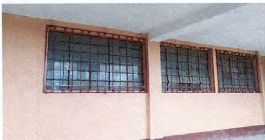
foto 17: sustitución de balcones de metal color rojo óxido 1.76 m x 1.31 m, 2.02 m x 1.31 m, 1.01 m x 1.31 m, 1.75 m x 1.31 m, 1.98 m x 1.31 m, 1.80 m x 1.35 m, 2.02 m x 1.35 m, 1.79 m x 1.35 m, 2.06 m x 1.35 m
