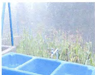
Foto 11: sustitución de llaves de chorros
