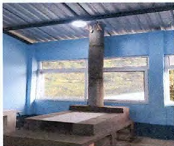
Foto13: sustitución de chimenea de metal por chimenea de cemento
