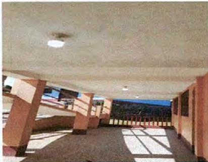
Foto 1: sustitución de bombillas ahorradoras
