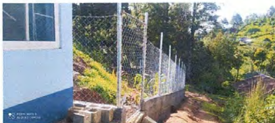
Foto 14: Reparación de muro perimetral de block con tubo hg y malla galvanizada
