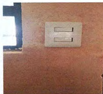
Foto 4: sustitución de interruptores doble
