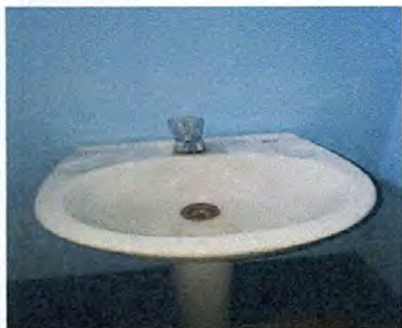
Foto7: sustitucion de llaves para lavamano
