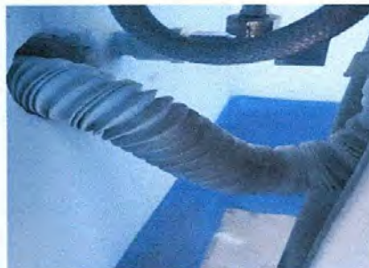
Foto 8: sustitución de llaves de paso para lavamanos
