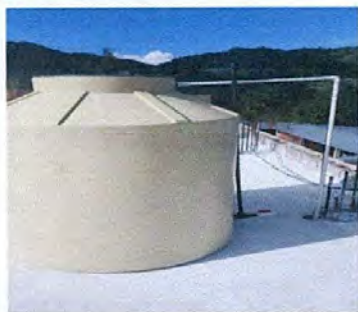
foto 15: sustitución de deposito de agua 1,100 lt
