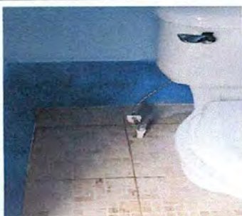
Foto 5: sustitución de mangueras de agua para inodoro
