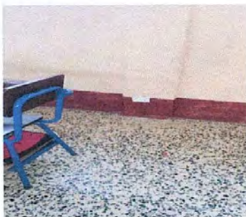
Foto 3: sustitución de tomacorriente
