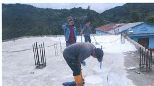
Foto 20: impermeabilización de losa (21 x 9 metros 2)
