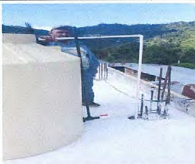
foto 15: sustitución de deposito de agua 1,100 lt
