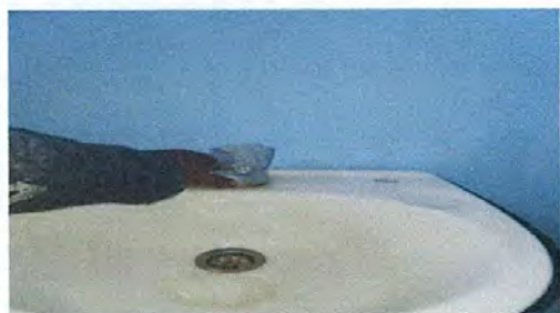
Foto 7: sustitución de llaves para lavamano
