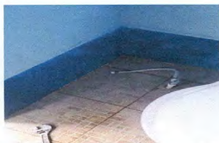
Foto 5: sustitución de mangueras de agua para inodoro
