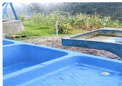
Foto 10: sustitución de pilas plasticas
