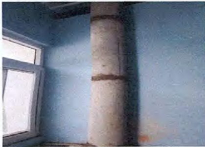
Foto 13: sustitución de chimenea de metal por chimenea de cemento
