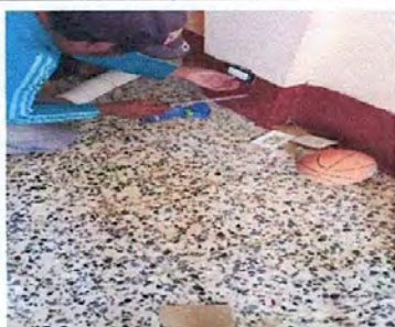
Foto 3: sustitución de tomacorriente
