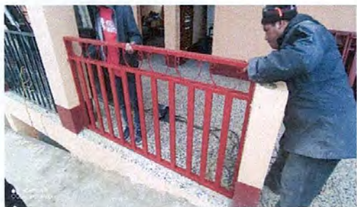
Foto 19: sustitución de barandas de metal (260 X100)(366 X100)(366 X 100)(214 X 100)(208 X 100)(115 X 100)(142 X 100)(366 X 100)(258 X 100)
