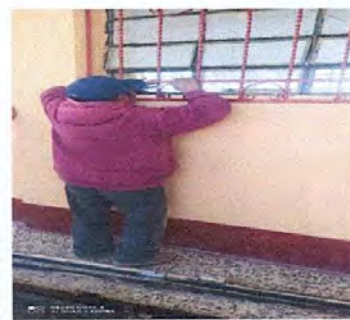
Foto 16: sustitución de vidrios de ventanas 32cm x 19cm
