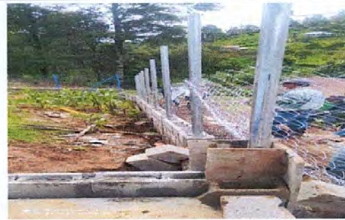
Foto 14: Reparación de muro perimetral de block con tubo hg y malla galvanizada
