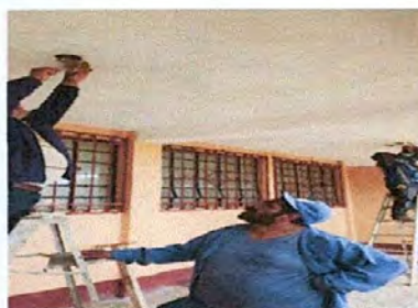
Foto 2: sustitución de plafoneras
