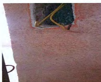
Foto 4: sustitución de interruptores doble
