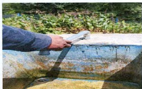
Foto 11: sustitución de llaves de chorros
