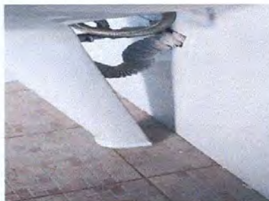
Foto 8: sustitución de llaves de paso para lavamanos
