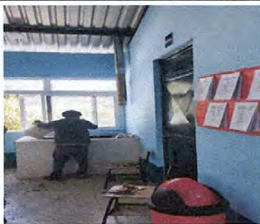
Foto13: sustitución de chimenea de metal por chimenea de cemento
