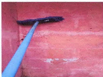
Foto 21: pintura en muros externos e internos (90 m2)
