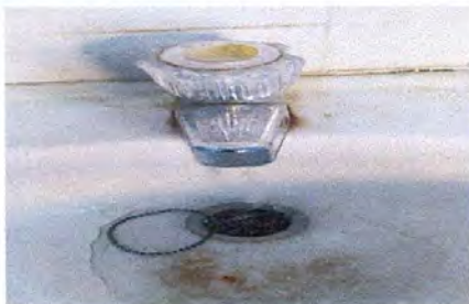
Foto 7: sustitución de llaves para lavamanos
