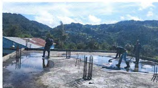
Foto 20: impermeabilización de losa (21 x 9 metros 2)
