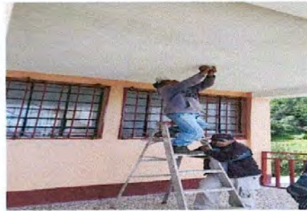
Foto 2: sustitucion de plafoneras
