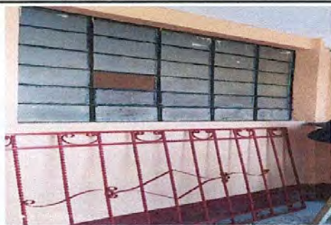
foto 17: sustitución de balcones de metal color rojo óxido 1.76 m x 1.31 m, 2.02 m x 1.31 m, 1.01 m x 1.31 m, 1.75 m x 1.31 m, 1.98 m x 1.31 m, 1.80 m x 1.35 m, 2.02 m x 1.35 m, 1.79 m x 1.35 m, 2.05 m x 1.35 m
