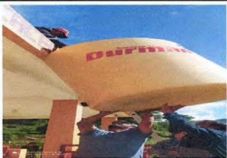
foto 15: sustitución de deposito de agua 1,100 lt
