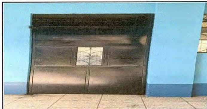
Foto 9: Sustrucción de chapas y mantenimiento de puertas
