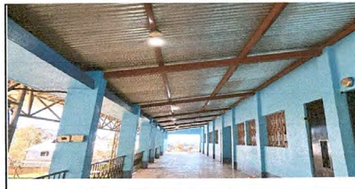
Foto 12: sustitución de focos por focos ahorradores
