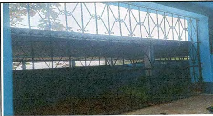
Foto 3: Mejoramiento de altura y ancho de una estructura metálica de baranda
