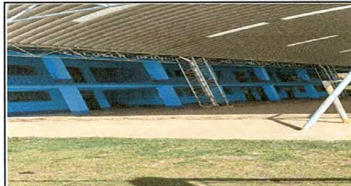
Foto 10: pintura en muros exteriores e interiores
