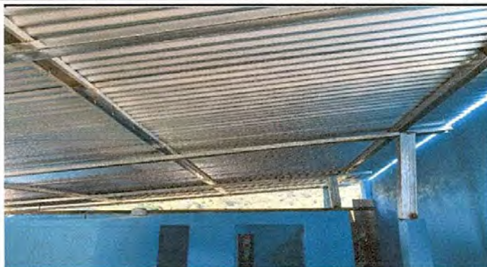
Foto 7: Sustrucción techo de baños: láminas acanaladas y vigas de madera por estructura metálicas (costaneras) con láminas acanaladas calibre 26
