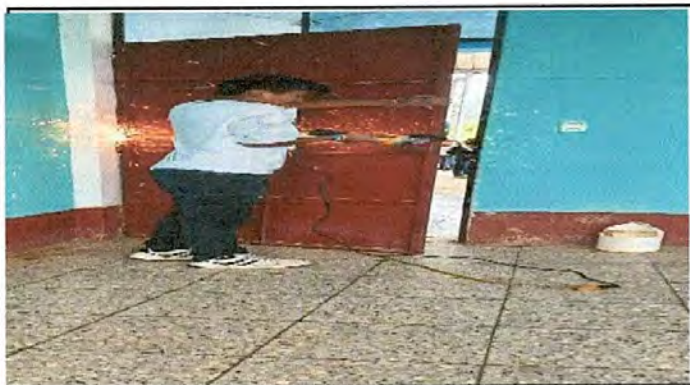
Foto 9: Sustrucción de chapas y mantenimiento de puertas
