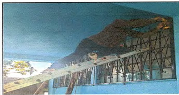
Foto 11: colocación de balcones a ventanas
