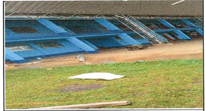
Foto 10: pintura en muros exteriores e interiores
