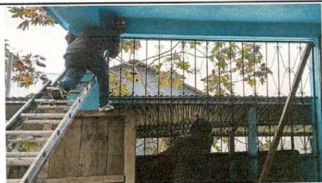
Foto 3: Mejoramiento de altura y ancho de una estructura metálica de baranda
