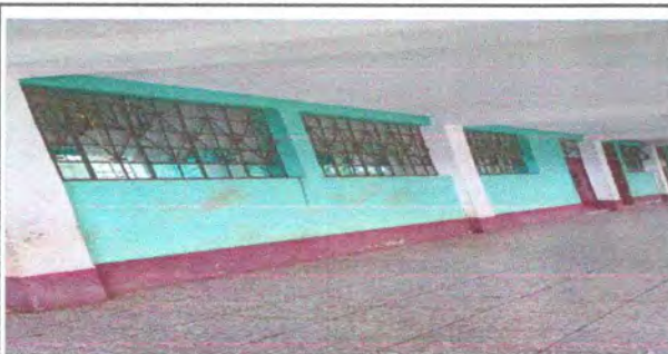
Foto 11: colocación de balcones a ventanas
