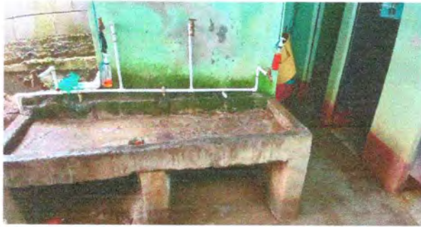
Foto1: Mejoramiento de lavamanos de concreto (colocación de azulejos)
