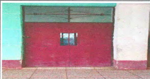
Foto 9: Sustitución de chapas y mantenimiento de puertas
