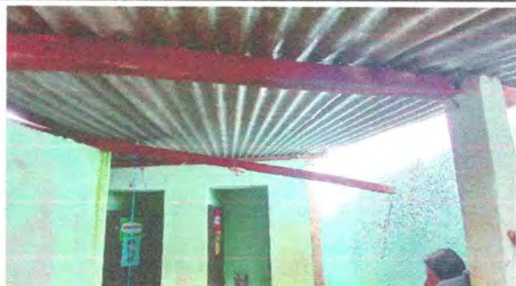
Foto7: Sustitución techo de baños: láminas acanaladas y vigas de madera por estructura metálicas (costaneras) con láminas acanaladas calibre 26
