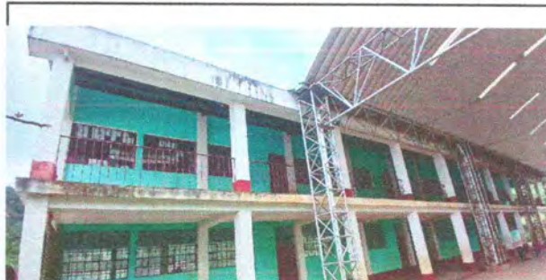
Foto 10: pintura en muros exteriores e interiores
