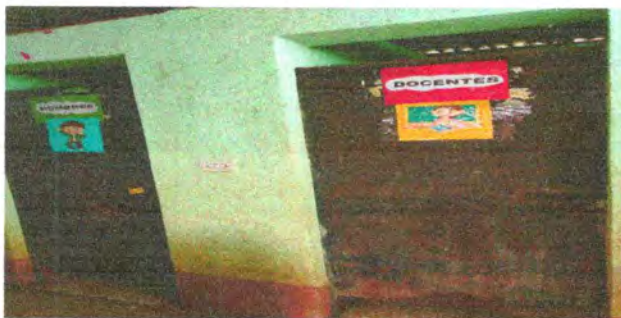
Foto 5: Puertas metálicas de baño: mantenimientos a estructura (lijada, cepillado, aplicación de pintura)
