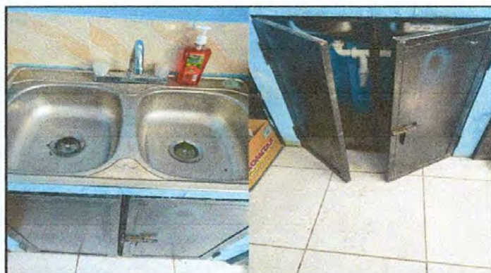
Foto 16: Sustitución de lavatrastos (incluye accesorios como llave de paso, uniones y tubos pvc y otros)
