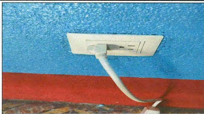
Foto 7: Sustitución de tomacorrientes dobles
