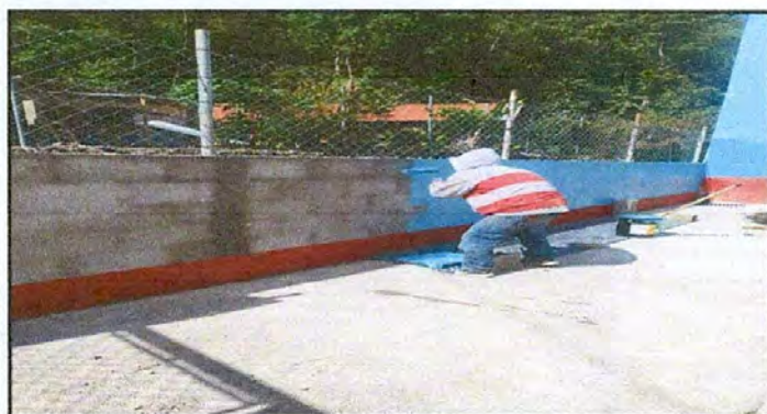
Foto 5: Pintura en muros exteriores e interiores
