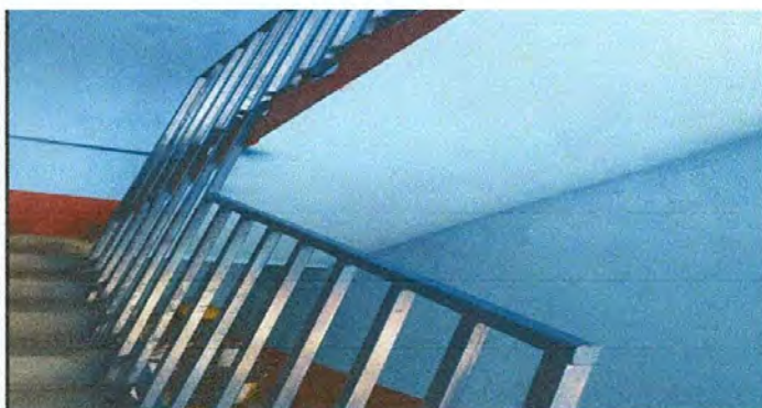
Foto 12: Mantenimiento a barandas de metal
