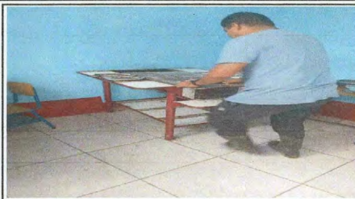
Foto 2: Sustitución de plancha de metal de 3 hornillas
