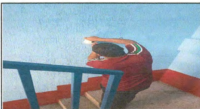
Foto 6: Sustitución de plafoneras
