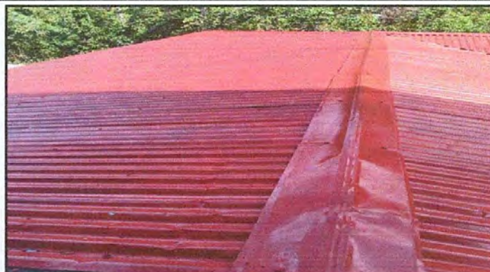
Foto 14: Mantenimiento a estructura de soporte de metal
