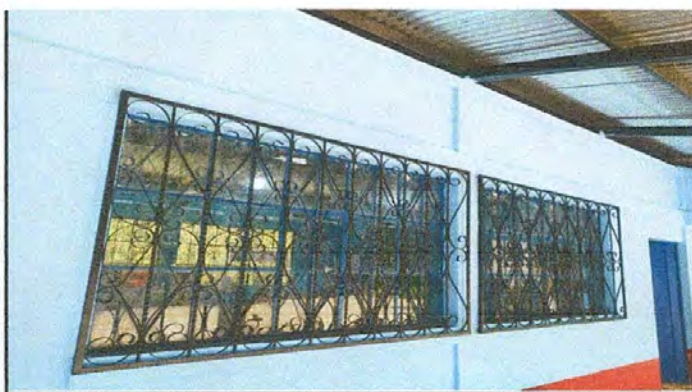
Foto 10: Sustitución de balcones de metal de 2.12 mx1.36m
