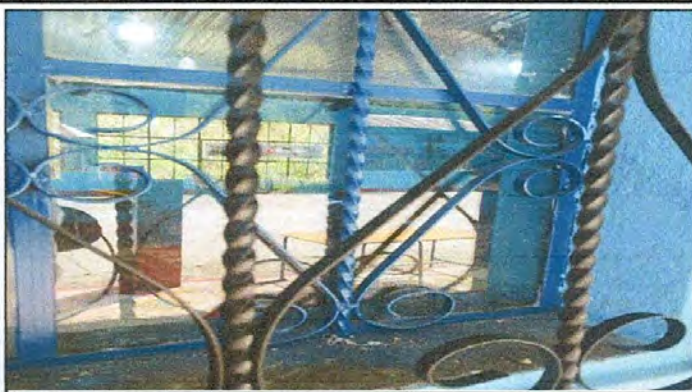
Foto 8: Sustitución de vidrios de 35cmx39cm.
