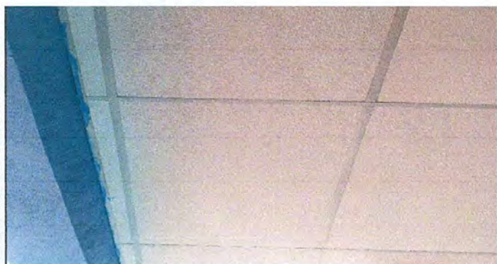
Foto 11: Sustitución de lámina, por lámina troquelada aluzinc calibre 26 1.15 m2
