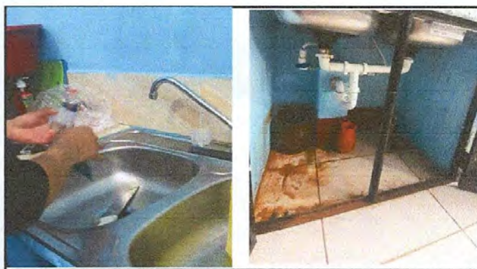
Foto 16: Sustitución de lavatrastos (incluye accesorios como llave de paso, uniones y tubos pvc y otros)
