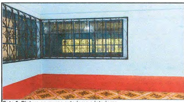
Foto 5: Pintura en muros exteriores e interiores
