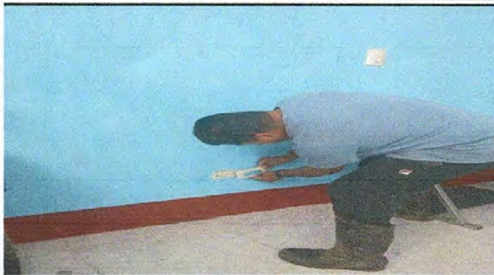
Foto 7: Sustitución de tomacorrientes dobles
