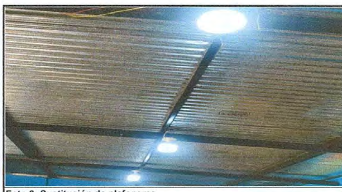
Foto 6: Sustitución de plafoneras
