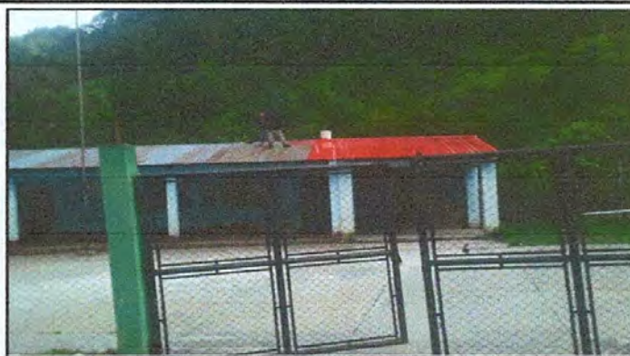
Foto 14: Mantenimiento a estructura de soporte de metal
