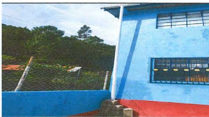
Foto 4: Reparación de bajada de agua pluvial, tubo PVC 3"
