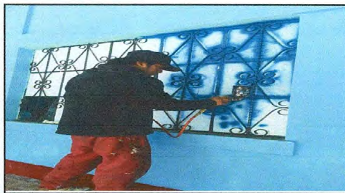
Foto 15: Mantenimiento a estructura de metal de ventana de 2.14mx1.18m.
