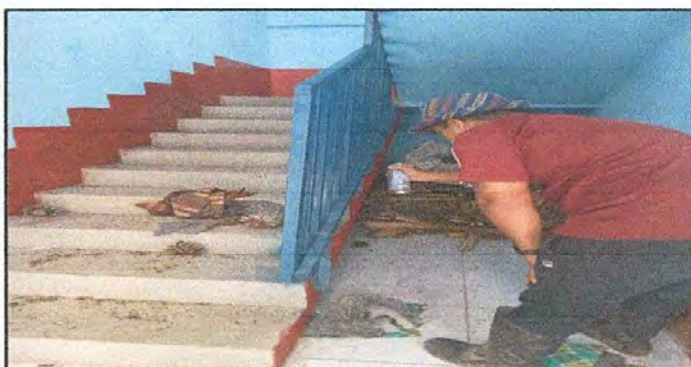
Foto 12: Mantenimiento a barandas de metal
