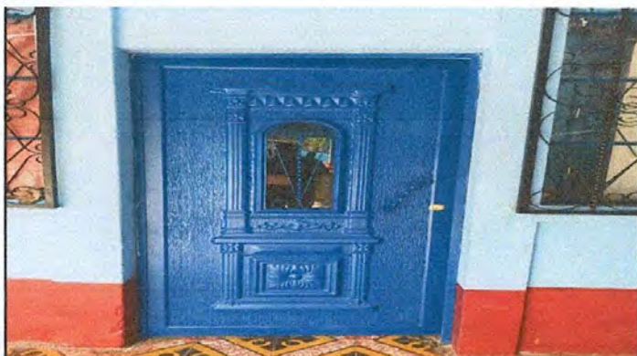
Foto 3: Sustitución de puertas de 1m x 2.9m
