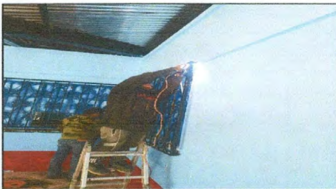
Foto 10: Sustitución de balcones de metal de 2.12 mx1.36m
