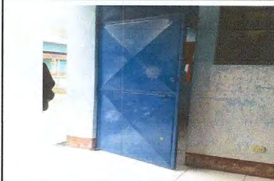
Foto 13: Mantenimiento a estructura (lijado, cambio de tubo, cepillado, sujeciones, aplicación de pintura) de 95cm x2.55m
