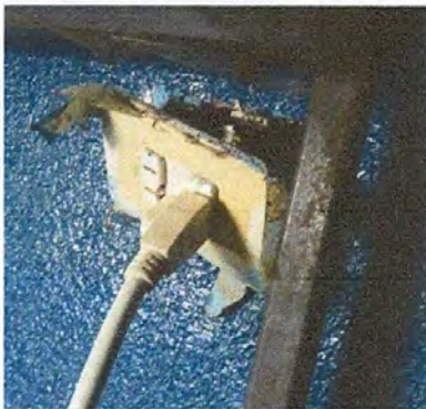
Foto 7: Sustrucción de tomacorrientes dobles
