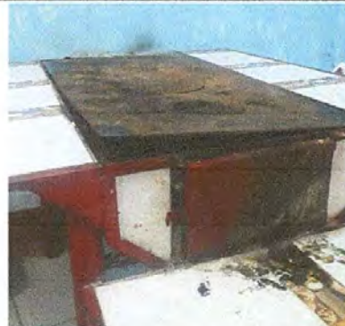
Foto 2: Sustitución de plancha de metal de 3 hornillas
