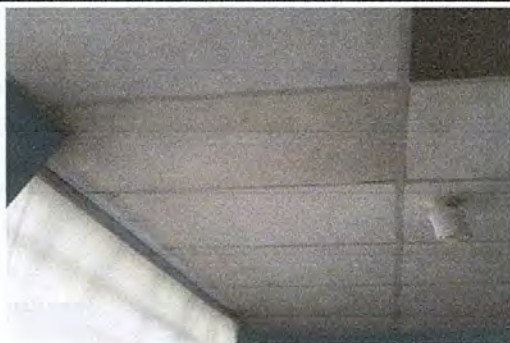
Foto 11: Sustrucción de lámina, por lámina troquelada aluzinc calibre 26 1.15 m2
