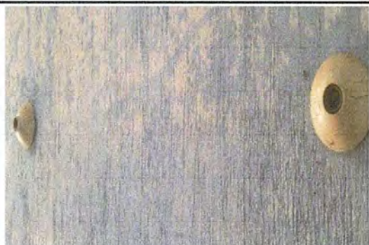
Foto 9: Sustrucción de focos ahorradores
