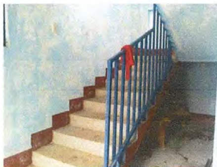
Foto 12: Mantenimiento a barandas de metal
