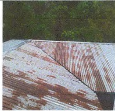
Foto 14: Mantenimiento a estructura de soporte de metal
