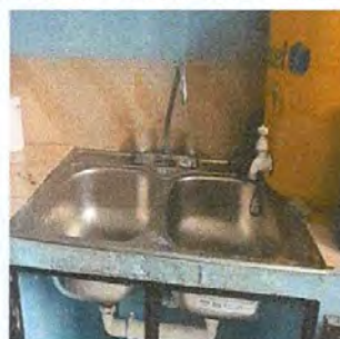
Foto 16: Sustitución de lavatrastos (incluye accesorios como llave de paso, uniones y tubos pvc y otros)
