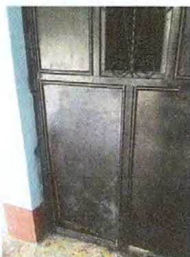
Foto 3: Sustitución de puertas de 1m x 2.9m
