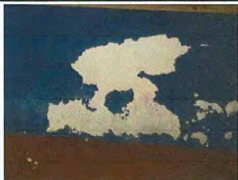
Foto 5: Pintura en muros exteriores e interiores
