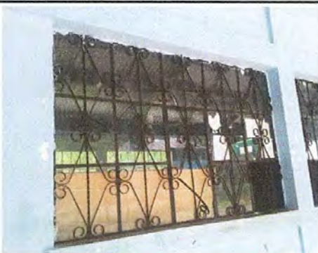
Foto 15: Mantenimiento a estructura de metal de ventana de 2.14mx1.18m.
