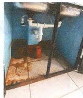
Foto 16: Sustitución de lavatrastos (incluye accesorios como llave de paso, uniones y tubos pvc y otros)
