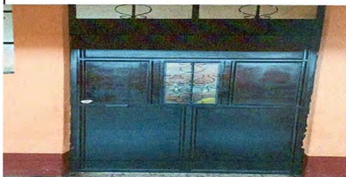
2. MANTENIMIENTO A ESTRUCTURAS DE PUERTAS.
