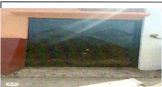
1. MANTENIMIENTO A PORTONES 4M2
