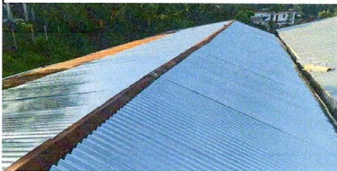
1. SUSTITUCION DE LAMINA, POR LAMINA ACANALADA CALIBRE 26
