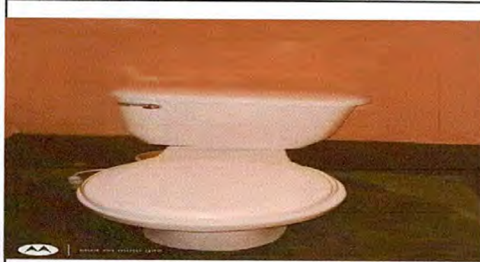
7. SUSTITUCION DE INODORO
