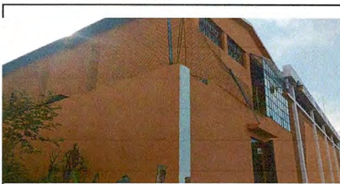
6. PINTURA EN MUROS EXTERNOS E INTERNOS
