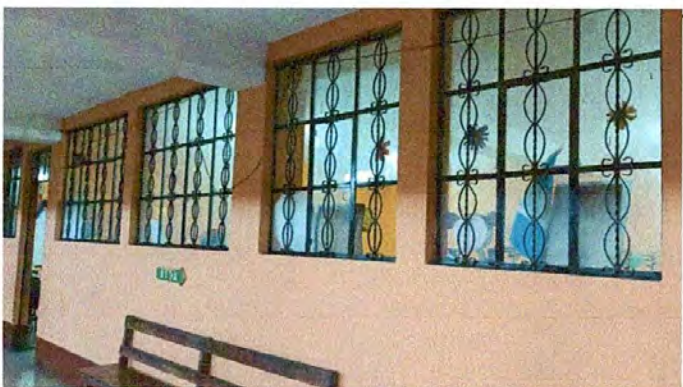
3. MANTENIMIENTO A ESTRUCTURAS DE VENTANA
