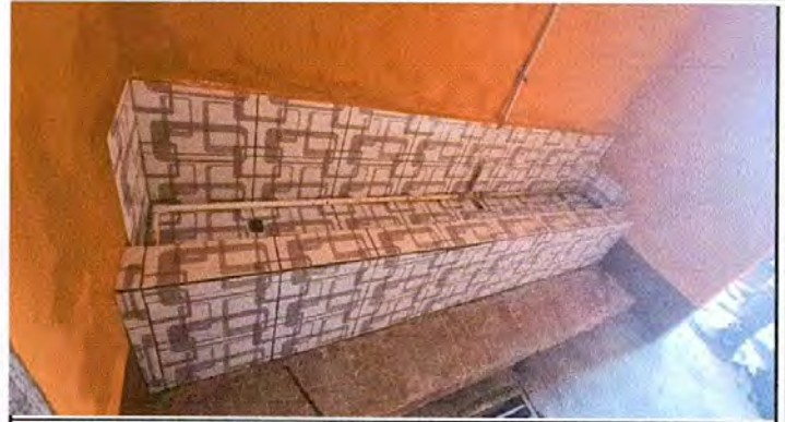
8. SUSTITUCION DE MINGITORIO
