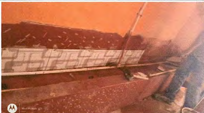
8. SUSTITUCION DE MINGITORIO
