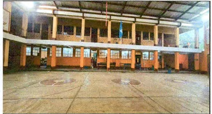
2. MANTENIMIENTO A ESTRUCTURAS DE PUERTAS.
