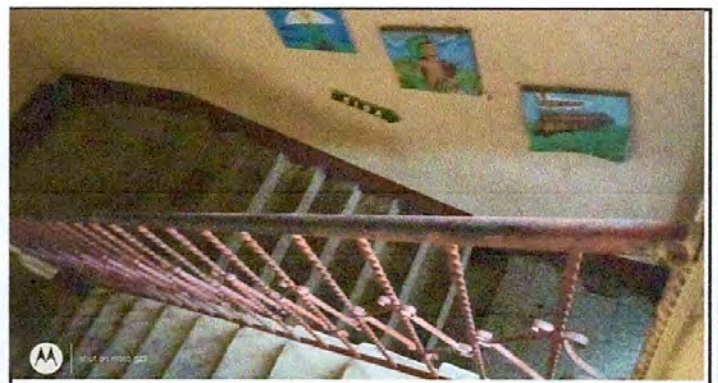
4.MANTENIMIENTO A BARANDAS.
