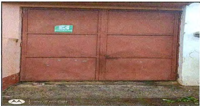
1. MANTENIMIENTO A PORTONES 4M2
