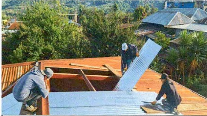
1. SUSTITUCION DE LAMINA, POR LAMINA ACANALADA CALIBRE 26
