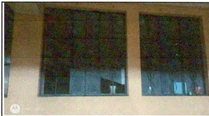
3. MANTENIMIENTO A ESTRUCTURAS DE VENTANA
