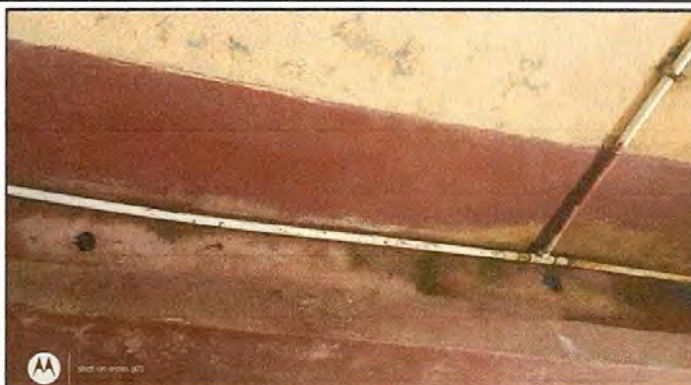
8. SUSTITUCION DE MINGITORIO
