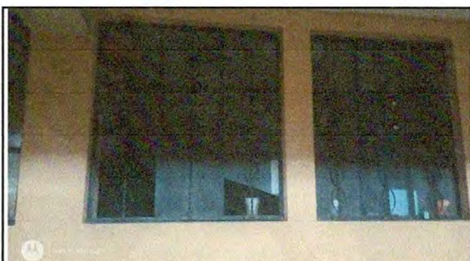
3. MANTENIMIENTO A ESTRUCTURAS DE VENTANA
