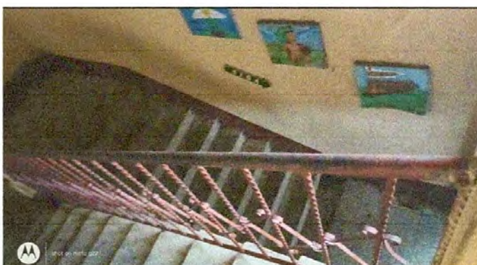
4. MANTENIMIENTO A BARANDAS.
