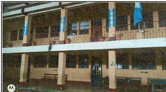
2. MANTENIMIENTO A ESTRUCTURAS DE PUERTAS.
