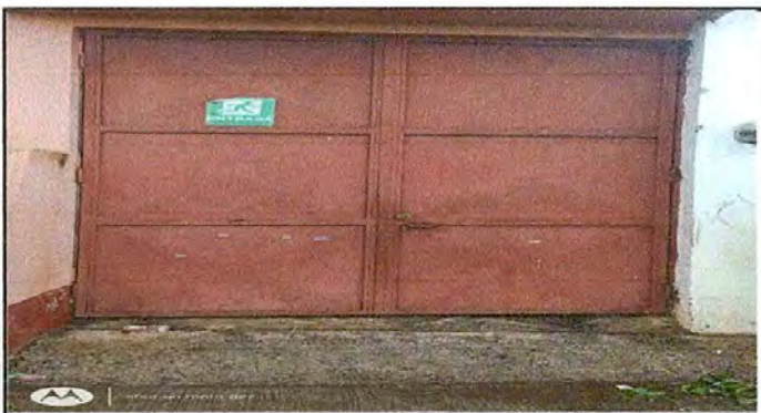
1. MANTENIMIENTO A PORTONES 4M2
