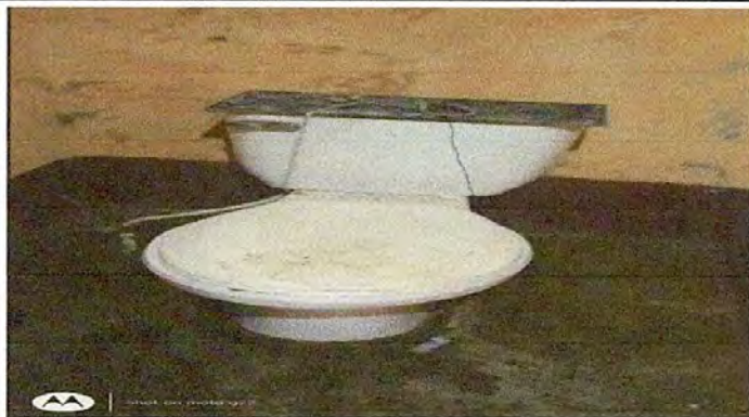
7. SUSTITUCION DE INODORO
