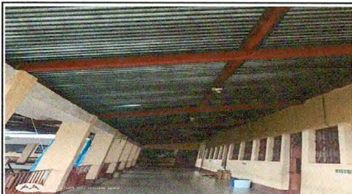
1. SUSTITUCION DE LAMINA, POR LAMINA ACANALADA CALIBRE 26
