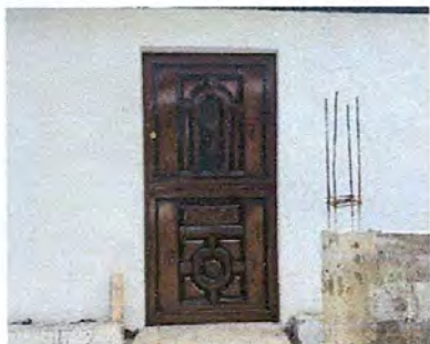
FOTO 7: Sustrucción de puerta de madera por puerta de metal, con chapa y marcos de metal, en módulo de cocina.
