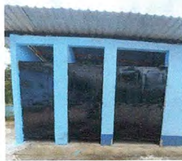
FOTO 2: Mantenimiento de estructura de puertas de metal (lijado, cambio de marco y aplicación de pintura). La pared se encuentra agrietada y los marcos no son anchos para sujetar cada puerta.
