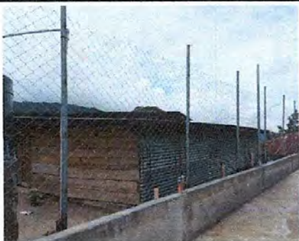
FOTO 9: Sustrucción de malla galvanizada en cerco de dos filas y tubo galvanizado.
