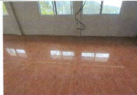
FOTO 6: Reparación de piso de torta de concreto en módulo de cocina.
