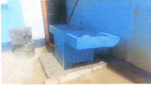
FOTO 1: Sustitución de pila de cemento, con tanque y 2 lavaderos. (se evidencia la falta de tanque y lavaderos adecuados)
