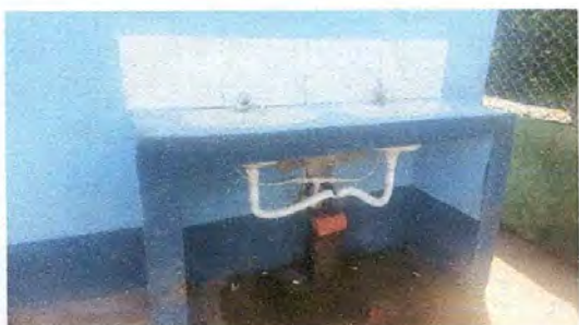
FOTO 3: Sustitución de accesorios de lavamanos en módulo de baños. (Se instalarán tubos flexibles, para asegurar el drenaje)
