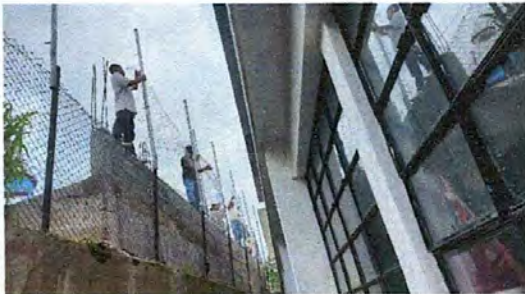
FOTO 9: Sustitución de malla galvanizada en cerco de dos filas y tubo galvanizado.
