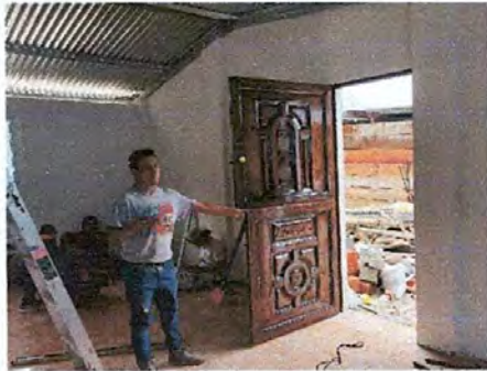
FOTO 7: Sustitución de puerta de madera por puerta de metal, con chapa y marcos de metal, en módulo de cocina.
