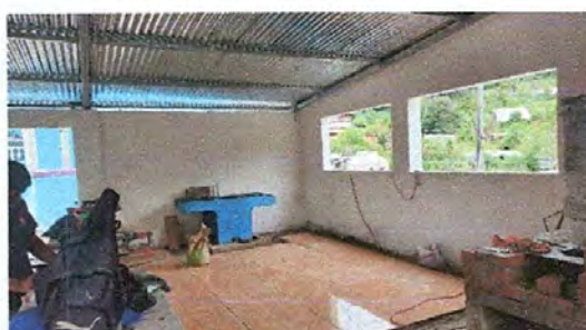
FOTO 6: Reparación de piso de torta de concreto en módulo de cocina.
