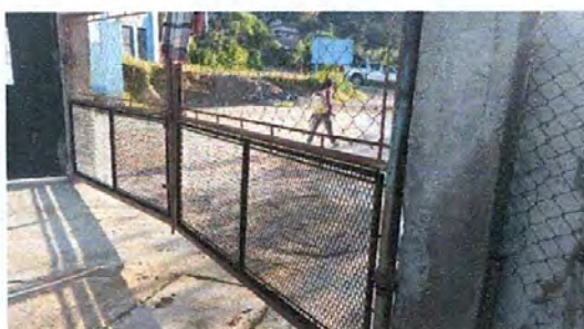
FOTO 4: Mantenimiento de portón de metal (lijado, cepillado y aplicación de pintura)
