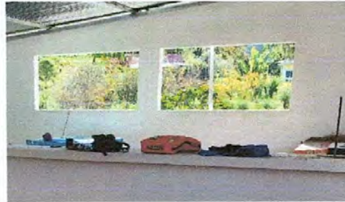
FOTO 8: Sustitución de ventana de madera por ventana de metal con vidrio.
