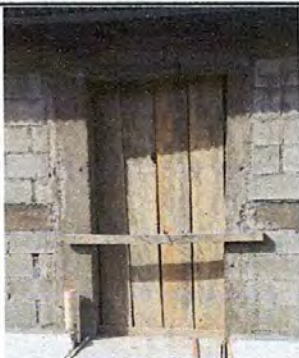
FOTO 7: Sustrucción de puerta de madera por puerta de metal, con chapa y marcos de metal, en módulo de cocina.
