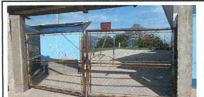
FOTO 4: Mantenimiento de portón de metal (lijado, cepillado y aplicación de pintura)
