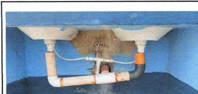
FOTO 3: Sustrucción de accesorios de lavamanos en módulo de baños. (Se instalarán tubos flexibles, para asegurar el drenaje)
