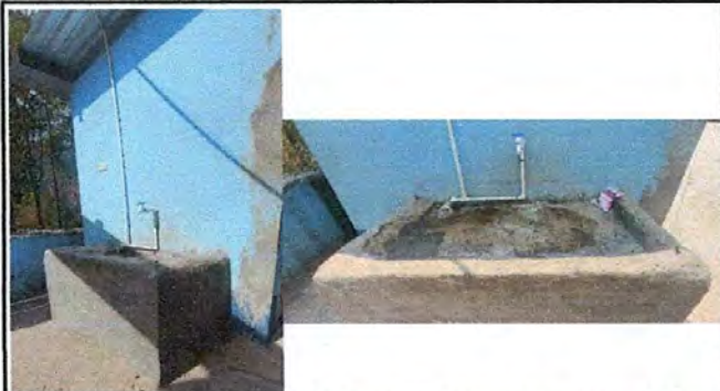
FOTO 1: Sustrucción de pila de cemento, con tanque y 2 lavaderos. (se evidencia la falta de tanque y lavaderos adecuados)
