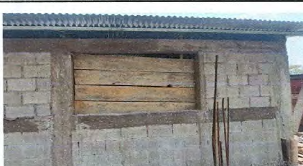
FOTO 8: Sustrucción de ventana de madera por ventana de metal con vidrio.
