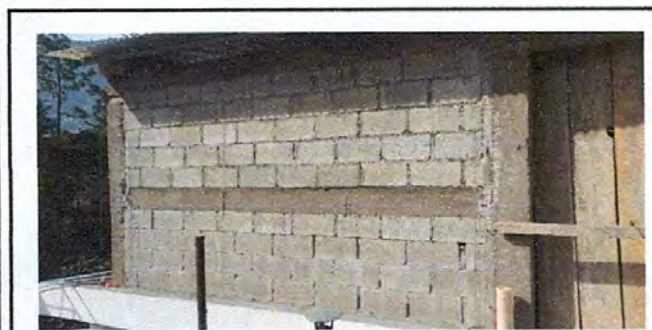
FOTO 5: Aplicación de repello y cernido de paredes en interior y exterior. Módulo de cocina.
