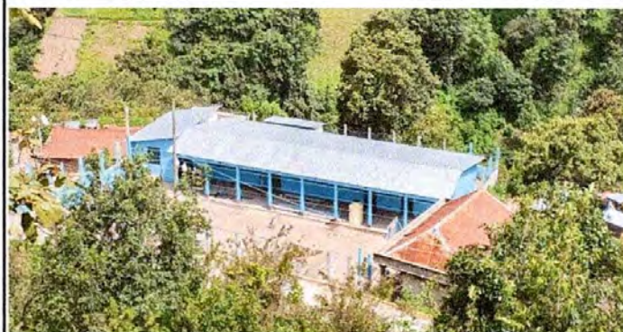
Foto1: Sustitución de lámina
