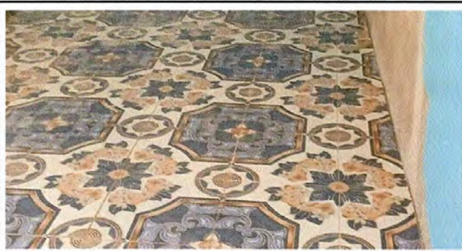
Foto 14: Sustrucción de piso por cerámico
