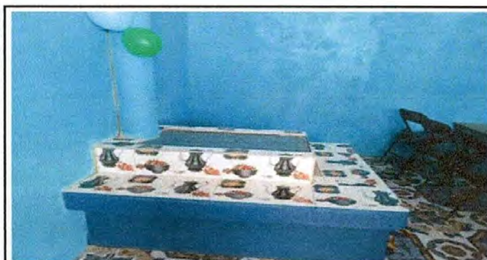
Foto 11: Instalación de azulejo
