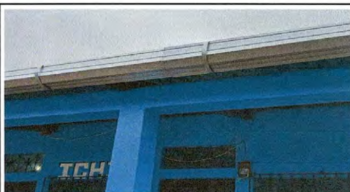
Foto 4: Sustitución de canal
