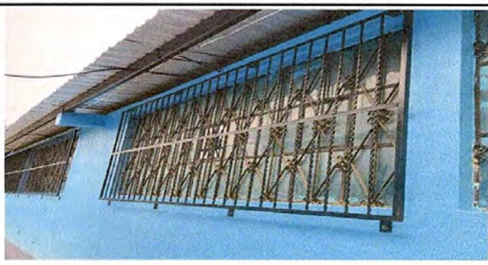
Foto 16: Fabricación e instalación de balcones
