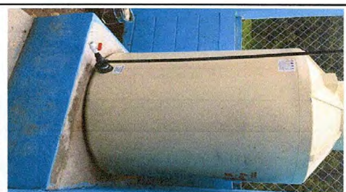
Foto 10: Sustrucción de depósito de agua
