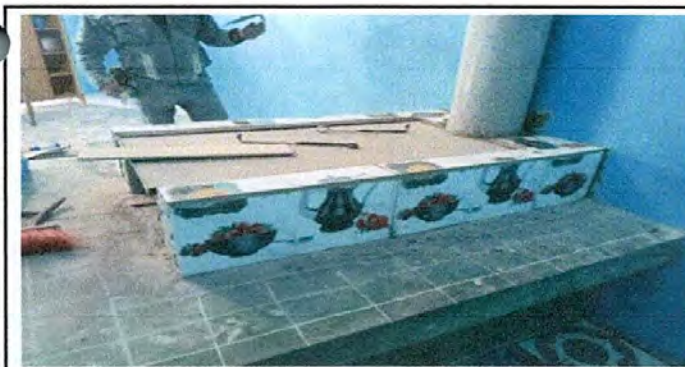
Foto 11: Instalación de azulejo
