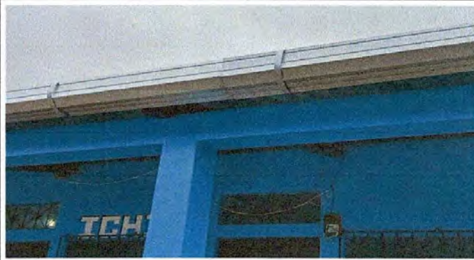
Foto 4: Sustitución de canal
