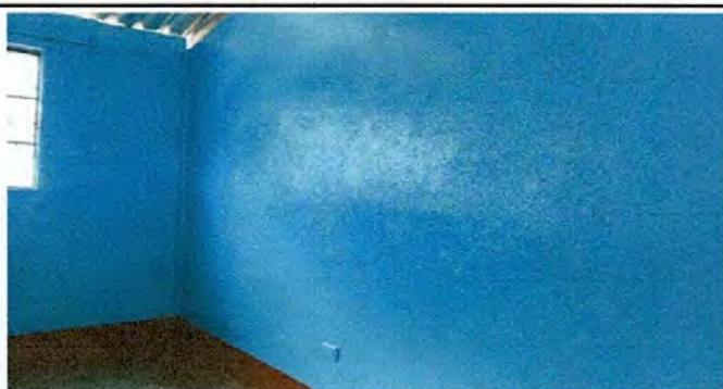
Foto 5: Pintura en muros exteriores e interiores
