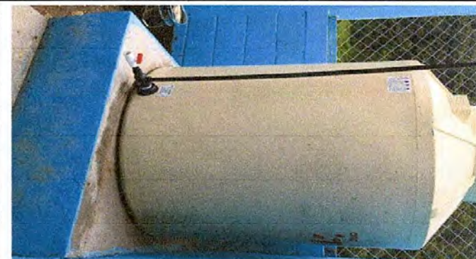
Foto 10: Sustitución de depósito de agua
