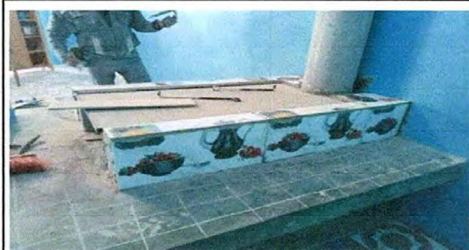
Foto 9: Sustitución de plancha
