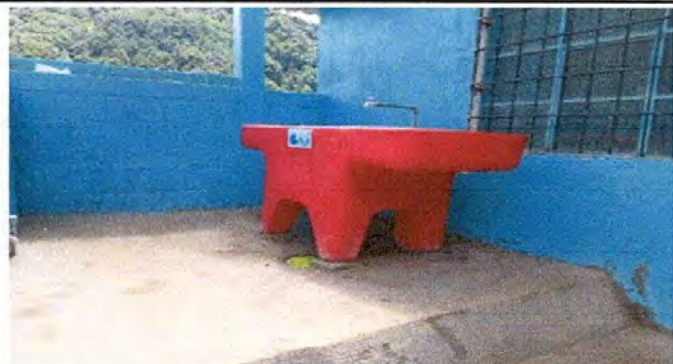
Foto 13: Sustitución de pila por pila de plástico
