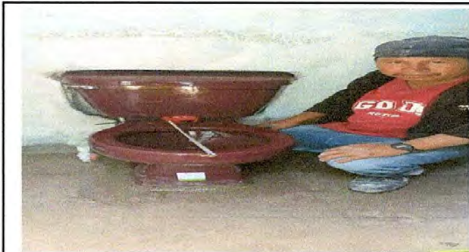
Foto7: Sustitución de inodoro
