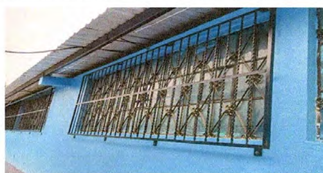
Foto 2: Sustitución de vidrios
