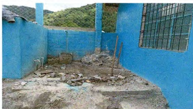
Foto 3: Reparación de piso
