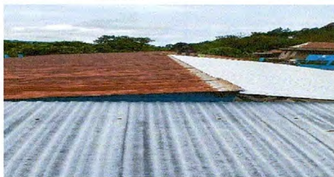
Foto1: Sustitución de lámina
