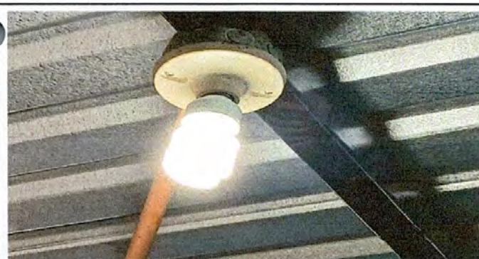
Foto 17: Sustitución de focos
