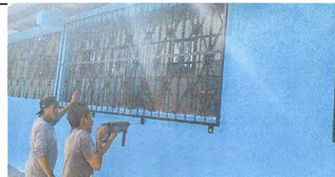
Foto 16: Fabricación e instalación de balcones
